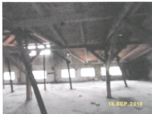
Pohled na zastřešení
