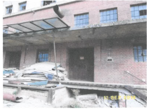
Pohled přední na vchod
