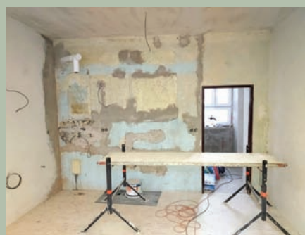
Probíhá rekonstrukce bytu na ulici Třebovské 71
