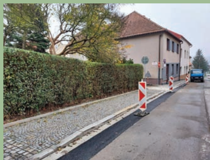
Společně s přeložkou ČEZ byl vybudován žulový chodník na Brněnské ulici
