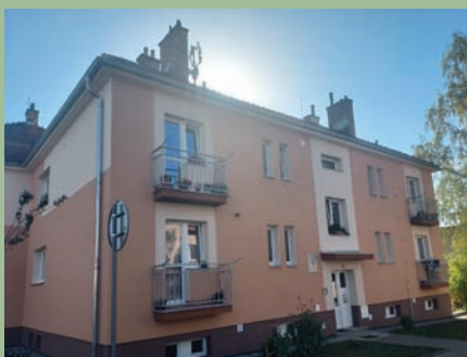
Dokončení zateplení bytového domu Nerudova 529
