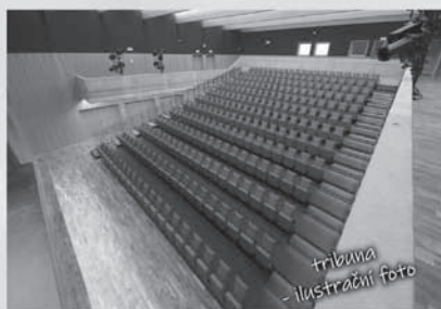
průběh stavby - sál
