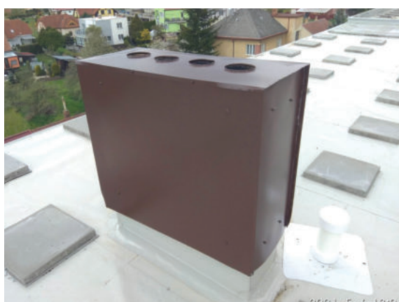
Oprava ploché střechy bytového domu M. Mikuláše 551
