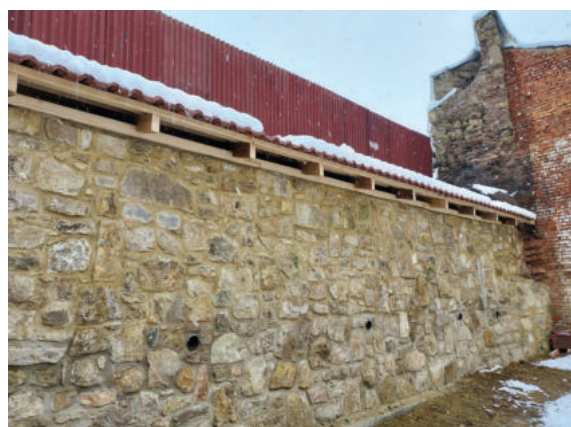
Obnova první části zřícených hradeb na Okružní IV
