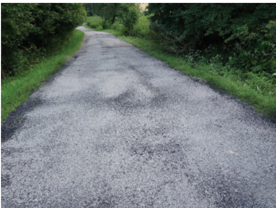
Lokální oprava příjezdové cesty na Mařín
