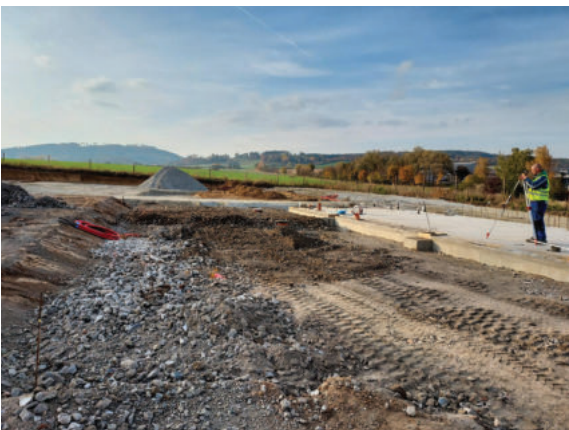
Realizace první etapy areálu nového sběrného dvora
