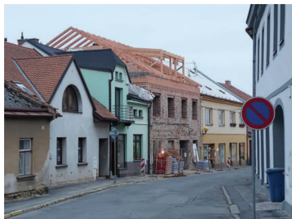
Zahájení komplexní rekonstrukce kina na víceúčelový sál
