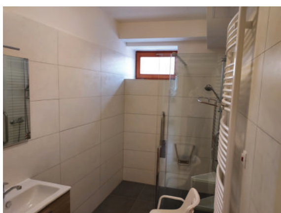
Rekonstrukce koupelny v centru osobní hygieny PS na Koblížně
