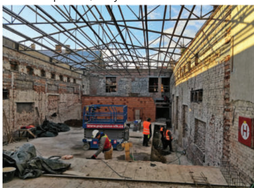
Pohled do rekonstruovaného sálu ASTRY
