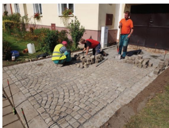
Zahájení zadláždění vjezdů na ulici Svitavské
