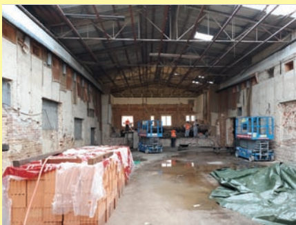
Budova kina se při kompletní rekonstrukci mění k nepoznání
