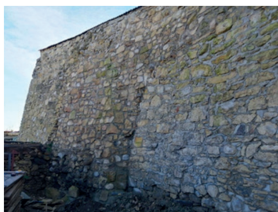
Oprava hradebního tělesa na Malém náměstí
