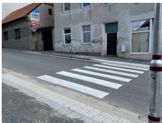
Nový přechod pro chodce na ulici Brněnské
