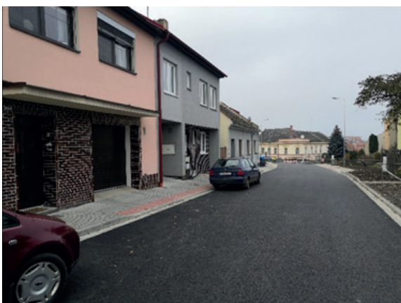
Komplexní rekonstrukce části ulice Okružní II
