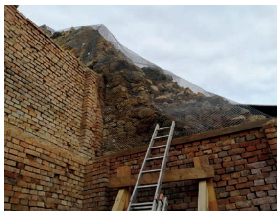
Zabezpečení zřícené části hradeb na Okružní IV
