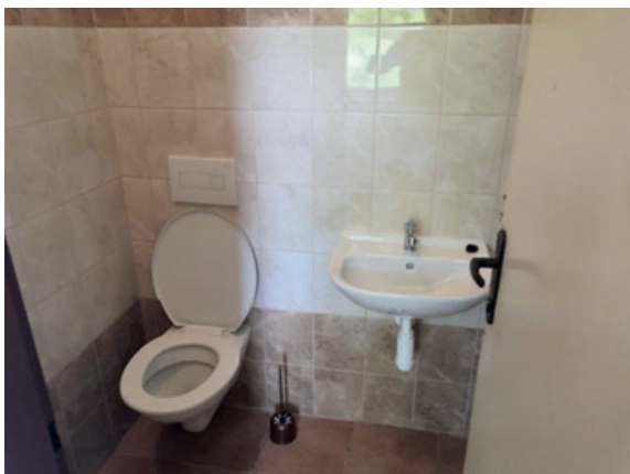
Rekonstrukce sociálního zařízení v ubytovně Soudní
