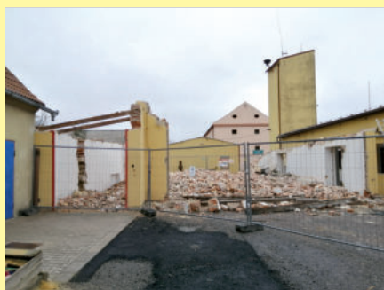
Proběhla demolice garáží hasičské zbrojnice
