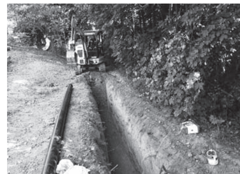
Probíhá oprava vodovodního řádu DN 150 u čp. 113 (Bomberovi), náklady 575 tis.Kč, inves- tor Svazek vodovodu Malá Haná, dotace Pardu- bický kraj 285 tis Kc
