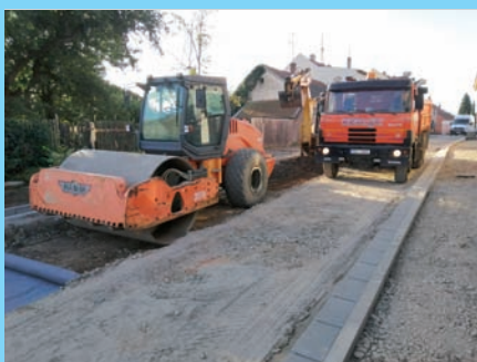
Na Okružní II probíhá realizace silnice a chodníků
