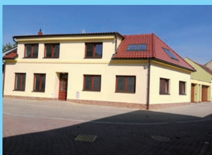
Dokončený bytový dům na ulici Barviřské
