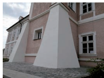
Oprava opěrných pilířů věže záměčku
