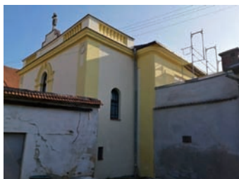
Obnova jižní fasády synagogy
