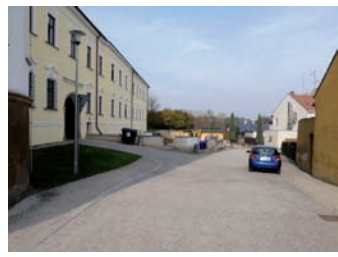
Komplexní rekonstrukce ulice Soudní
