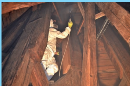
Zasažené dřevěné konstrukce městské věže prošly biocidním ošetřením
