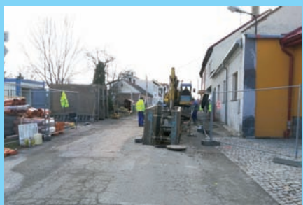
Zahájili jsme komplexní rekonstrukci druhého úseku ulice Okružní II
