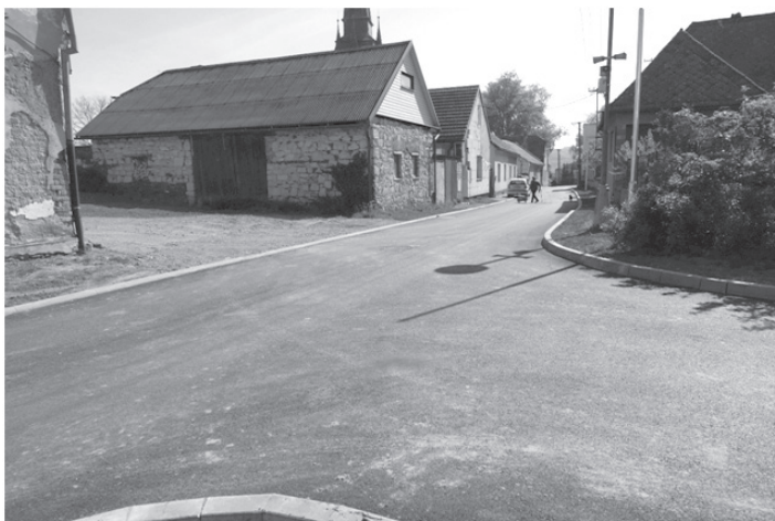
Kostelní ulice po rekonstrukci
