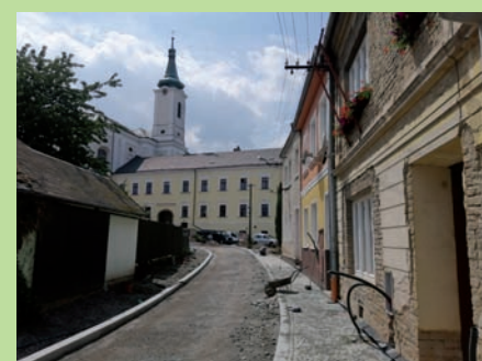
Na ulici Soudní už probíhá dláždění komunikace a chodníku
