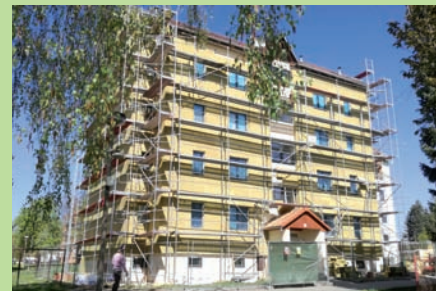
Zateplování bytoven na sídlišti K. Čapka je v plném proudu
