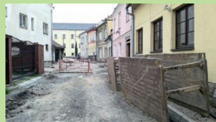
Rozběhla se kompletní oprava ulice Soudní
