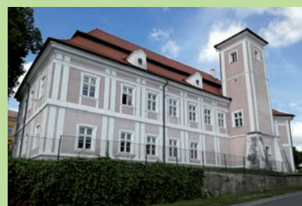
Opěrná zeď pod zámečkem se letos dočká opravy
