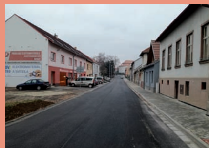
2. etapa rekonstrukce ul. Okružní IV je u konce
