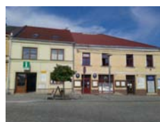
Nová střecha MěÚ Jevíčko
