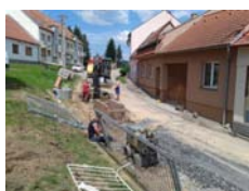
Vodovod a kanalizace Okružní IV
