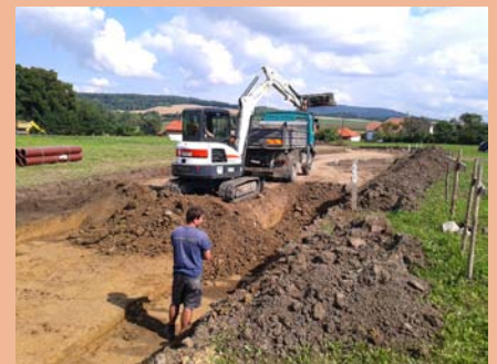
Na ulici Vrchlického začaly pracovat stroje
