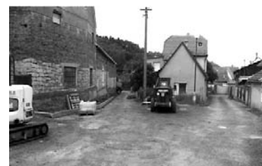
Rekonstrukce místní komunikace Vidléky
