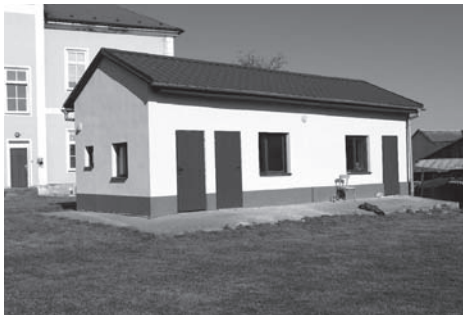
Nová střecha a fasáda – kabiny u fotbalového hřiště
