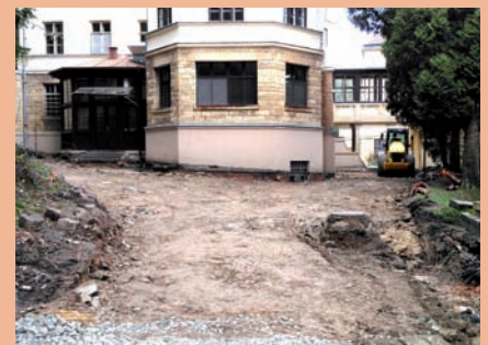
V Odborném léčebném ústavu se rozběhla rekonstrukce hlavní příjezdové komunikace, která postupně proběhne až k vrátnici u jezdu do areálu
