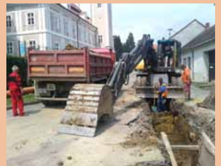
Rekonstrukce na ulici Okružní IV zahájena
