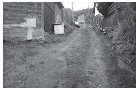
Oprava místní komunikace na Zálesí od čp. 18 po čp. 26 před opravou
