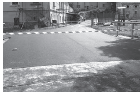
Nová část místní komunikace u areálu bývalého JZD po opravě
