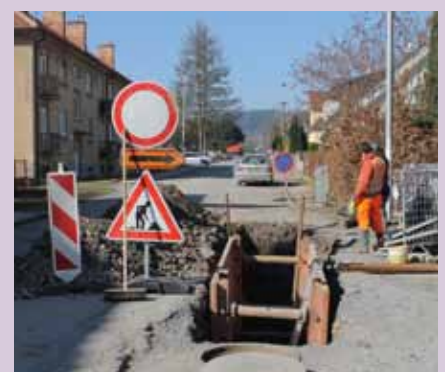
Zahájení opravy ulice Nerudovy v Jevíčku
