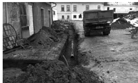
Pokračují stavební práce na technickém zázemí obce v bývalém areálu JZD.
