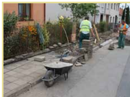
Oprava chodníků U cihelny
