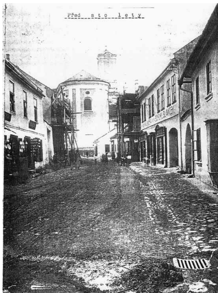
Kostelní ulice roku 1913 : vpravo -stavba Katolického domu na poschodí - kino vlevo -stavba domu č.p. 45 František Japíček
