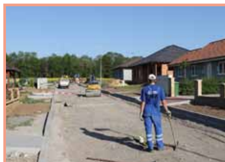
Komunikace na Mackerleho ul.
