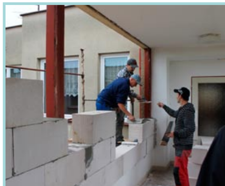
Na školce probíhá stavební ruch
