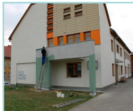
Oprava na nové DPS
