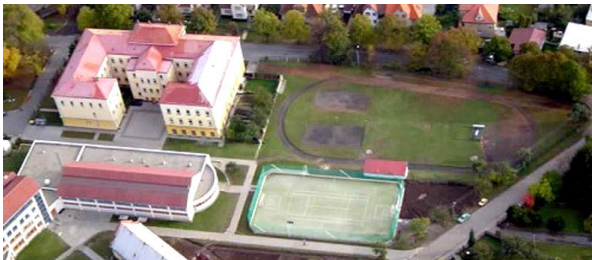
Obr. č. 4: Sportovní hřiště s umělým povrchem
