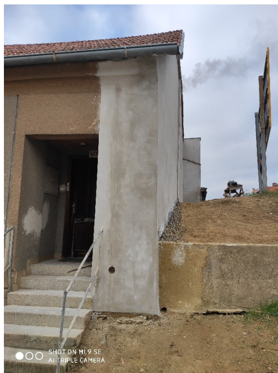
Třebovská 421 po opravě
