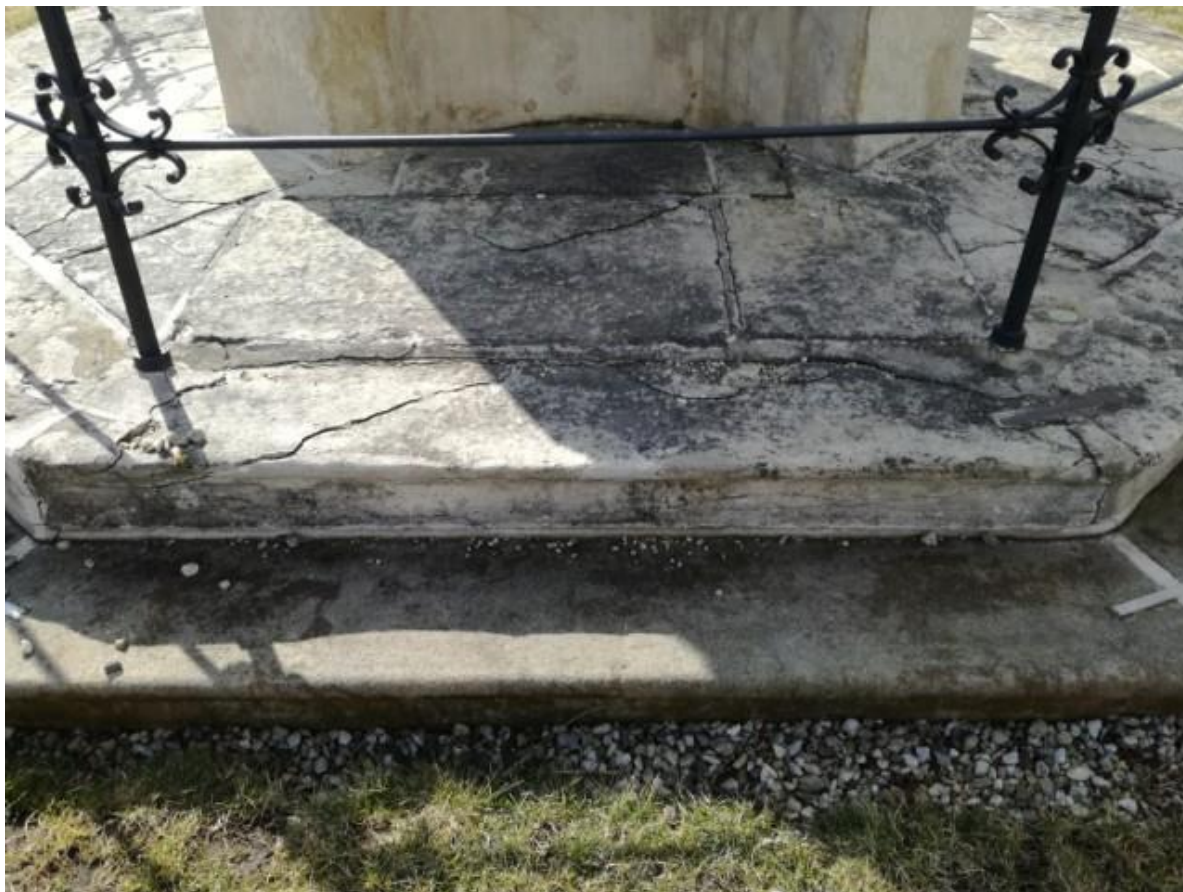
Fotografie před a po výměně dlažby vč. vnitřních schodů v roce 2018:
