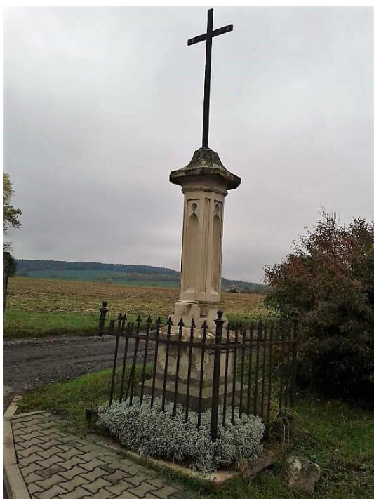
Fotografie kříže na ulici Horní – stav před a po obnově:
