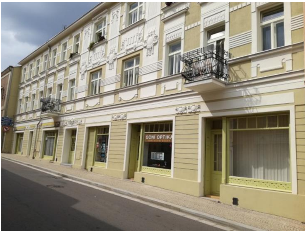
Fotografie po obnově soklové části na průčelí městského domu čp. 71 v roce 2018:
