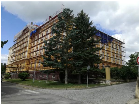
Fotografie z opravy střechy:
