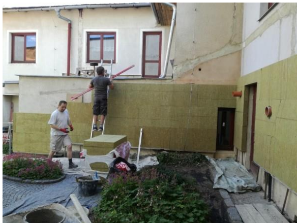
Fotografie dvorní části budovy:
