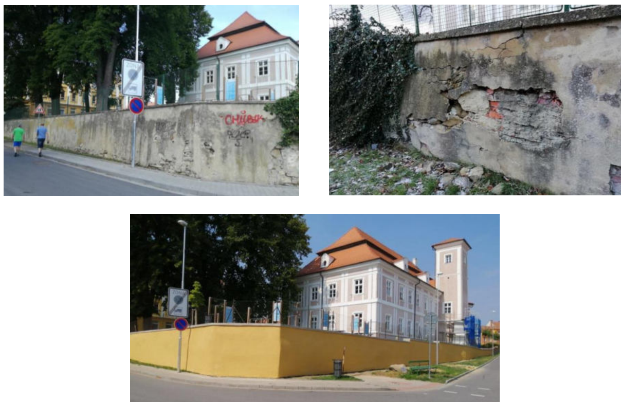
Fotografie před a po obnově opěrné zdi zámku v r. 2019:
