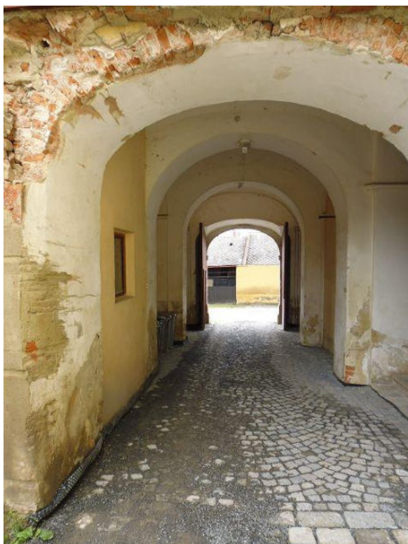
Fotografie před a po obnově průjezdu do dvorního traktu v r. 2014:
