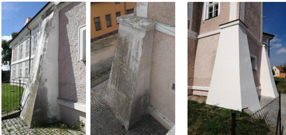
Fotografie před a po obnově pilířů věže zámku v r. 2019:
