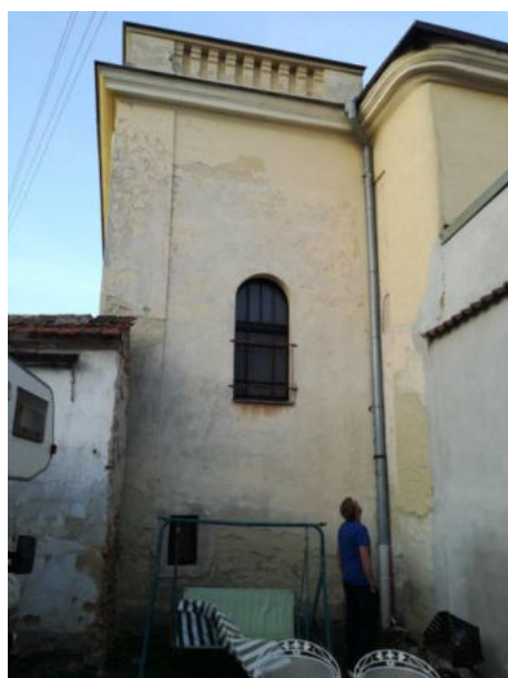
Fotografie před a po obnově fasády na jižní straně synagogy v r. 2019:
