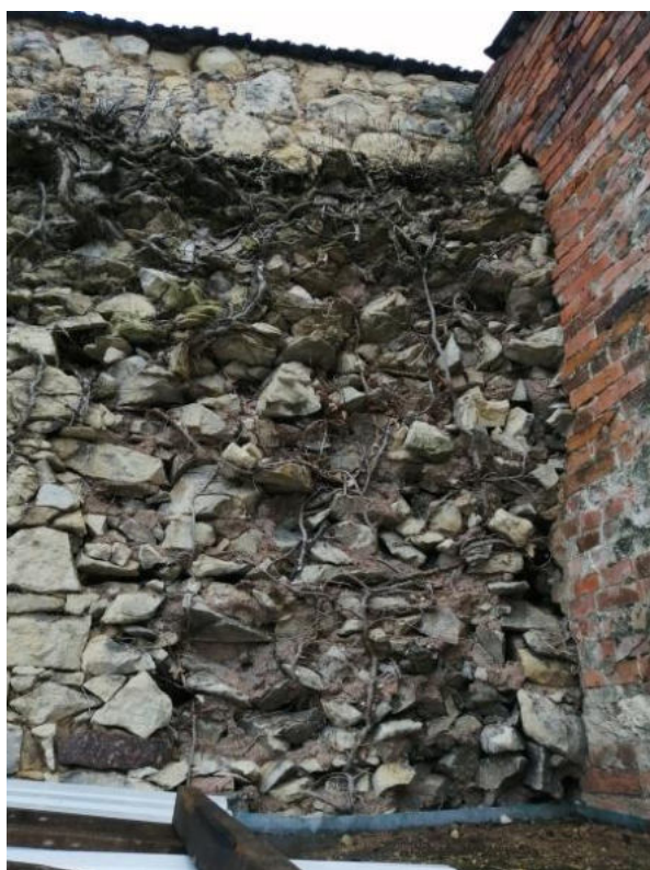
Fotografie před a po obnově městského opevnění v r. 2020:
