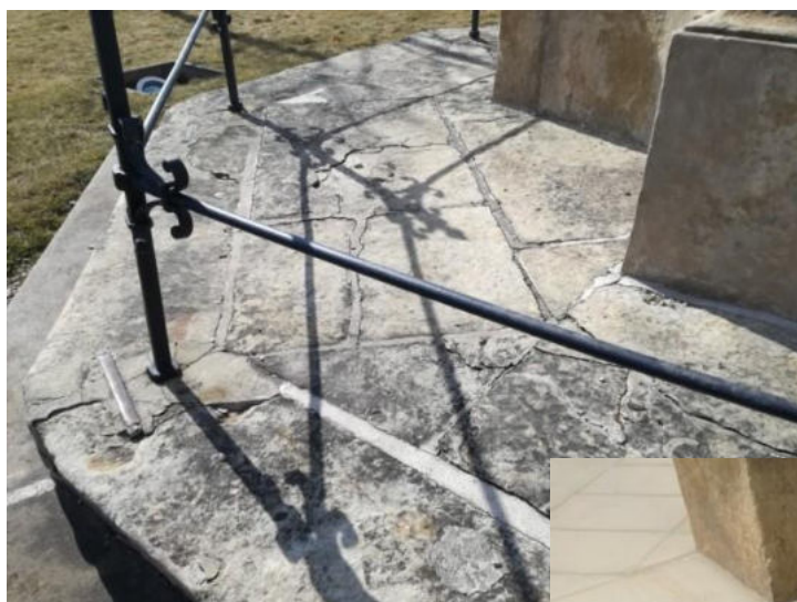
Fotografie před a po výměně dlažby vč. vnitřních schodů v r. 2018:
