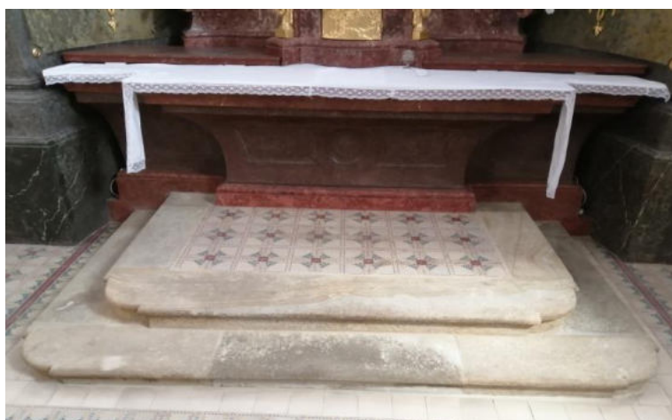
Fotografie před a po restaurování schodiště s podestou v r. 2019:
