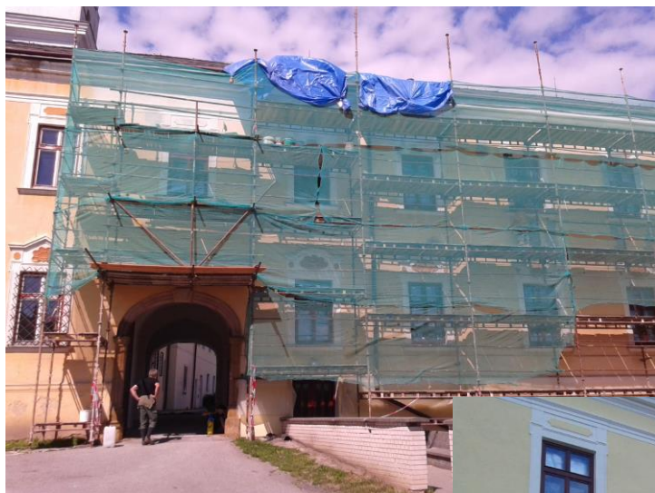
Fotografie z obnovy fasády na severním a východním křídle prelatury v roce 2016:
