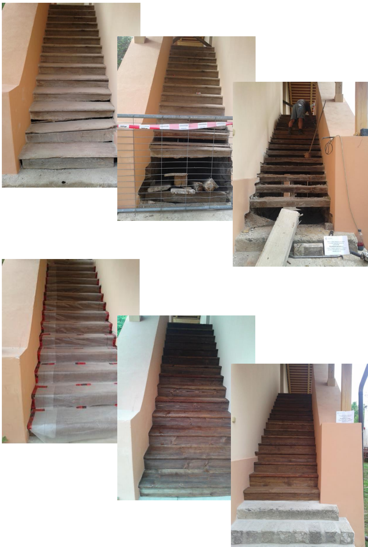
Fotografie z realizace obnovy vstupního oboustranného schodiště v roce 2016:
