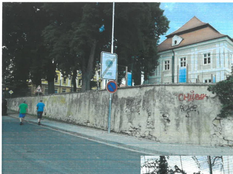
Fotografie před a po obnově opěrné zdi zámku v roce 2019:
