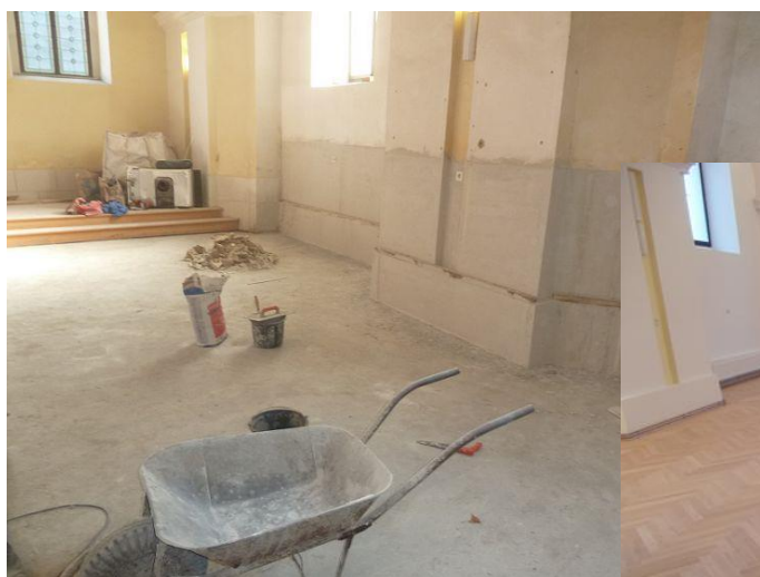
Fotografie z realizace oprav a po výměně podlahy:
