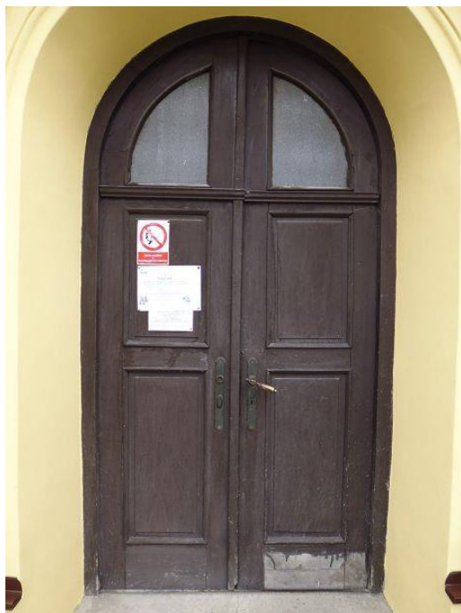
Fotografie vstupních dveří do synagogy před a po výměně:
