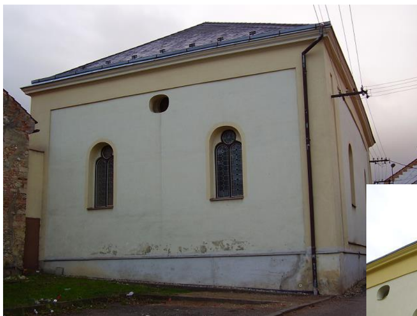
Fotografie před a po obnově omítky:
