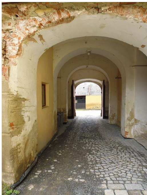
Fotografie před a po obnově průjezdu do dvorního traktu:
