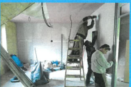
Na stavbě bytového domu Barvířská 560 se pracuje v interiéru
