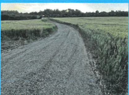
Město provedlo vyspravení polních obslužných cest do zahrádkářských kolonií na Červeném kopci
