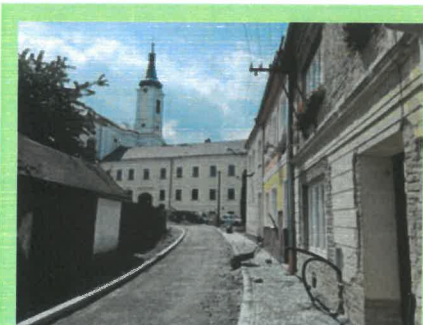
Na ulici Soudní už probíhá dláždění komunikace a chodníku
