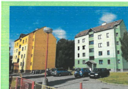
Dokončili jsme vnější zateplení bytových domů na sídlišti K. Čapka
