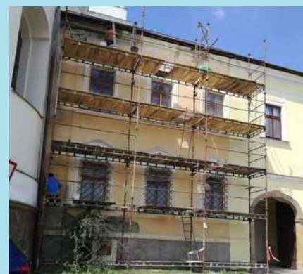
Farní část fasády kláštera bude opravena z dotace MK
