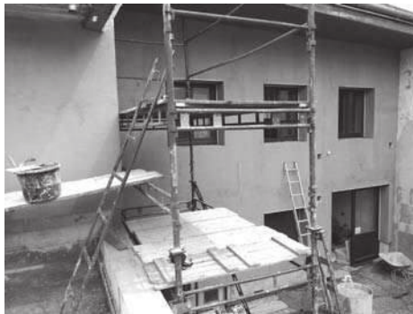
Zateplování budovy MěÚ Jevíčko
