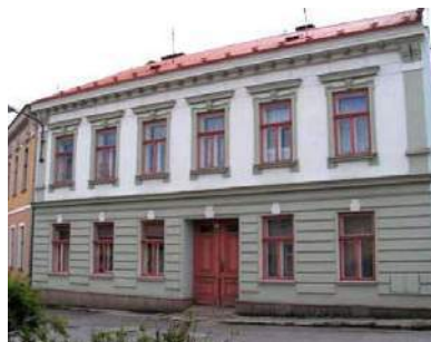
Obr.: průčelí secesní fasády č. p. 98
