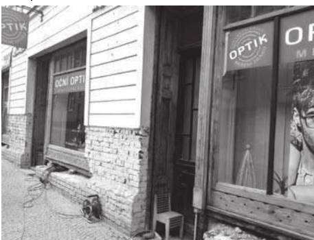
Restaurování výkladců domu Třebovská 71
