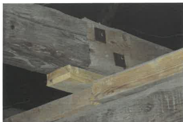
provedené opravy 3.NP
