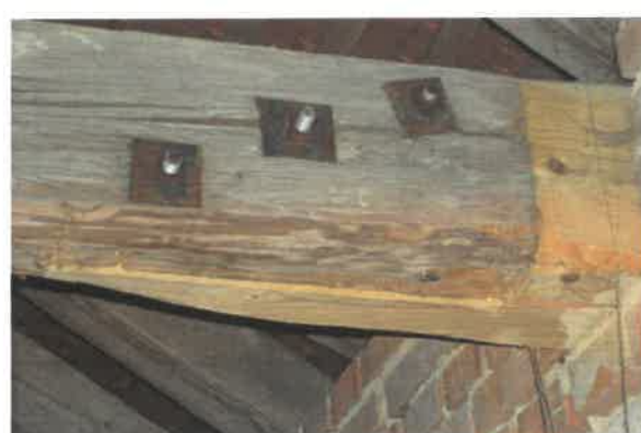
opravené zhlaví 3.NP
