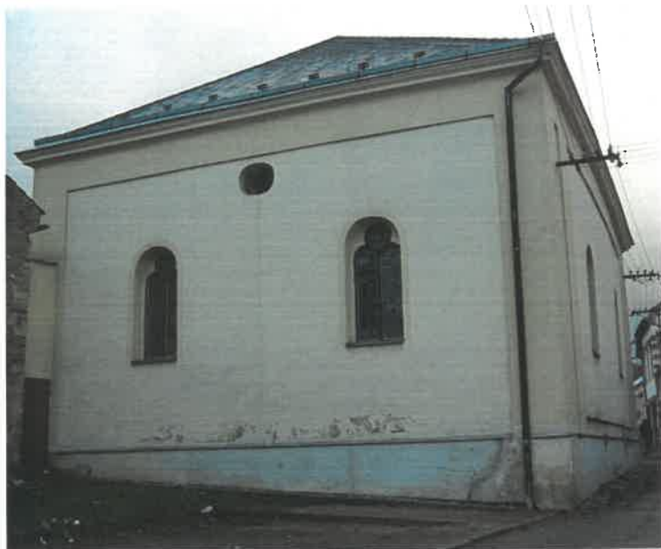
Fotografie před a po obnově fasády na východní a severní straně synagogy v r. 2013:
