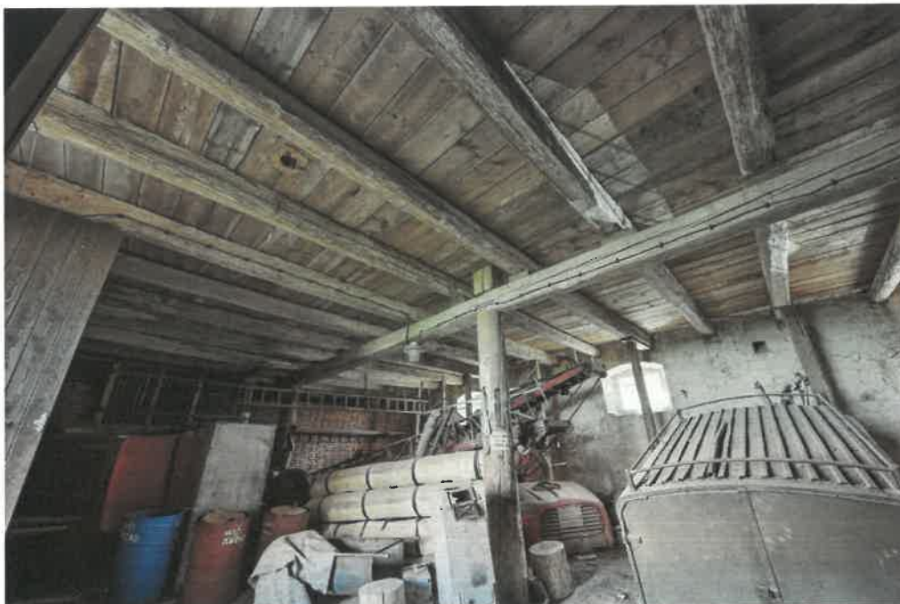
5. Prostor 1. nadzemního podlaží - pohled k severní části.
