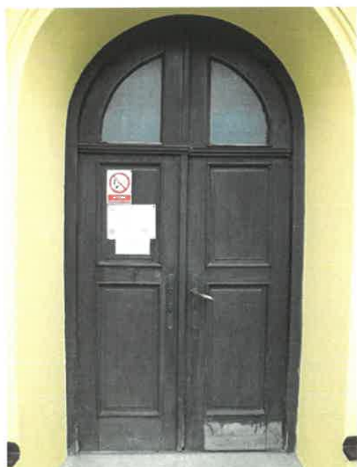
Fotografie před a po výměně vchodových dveří v r. 2013:
