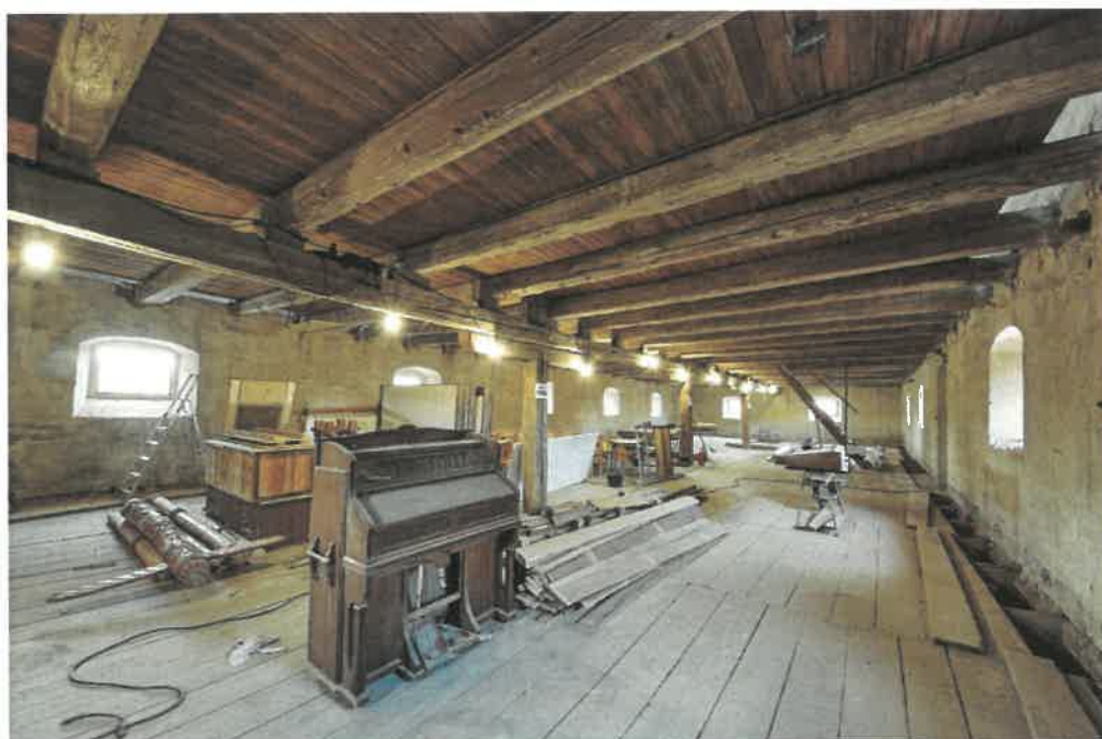
14. Prostor 2. nadzemního podlaží - pohled k severní části
