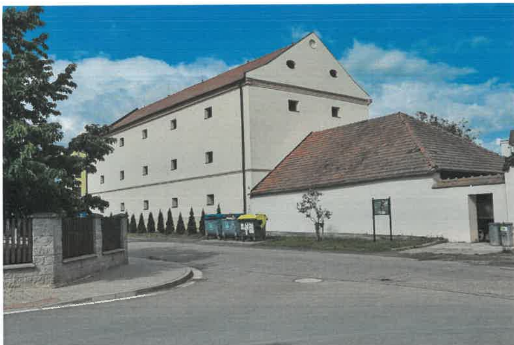
1. Pohled na sýpku od západu.
