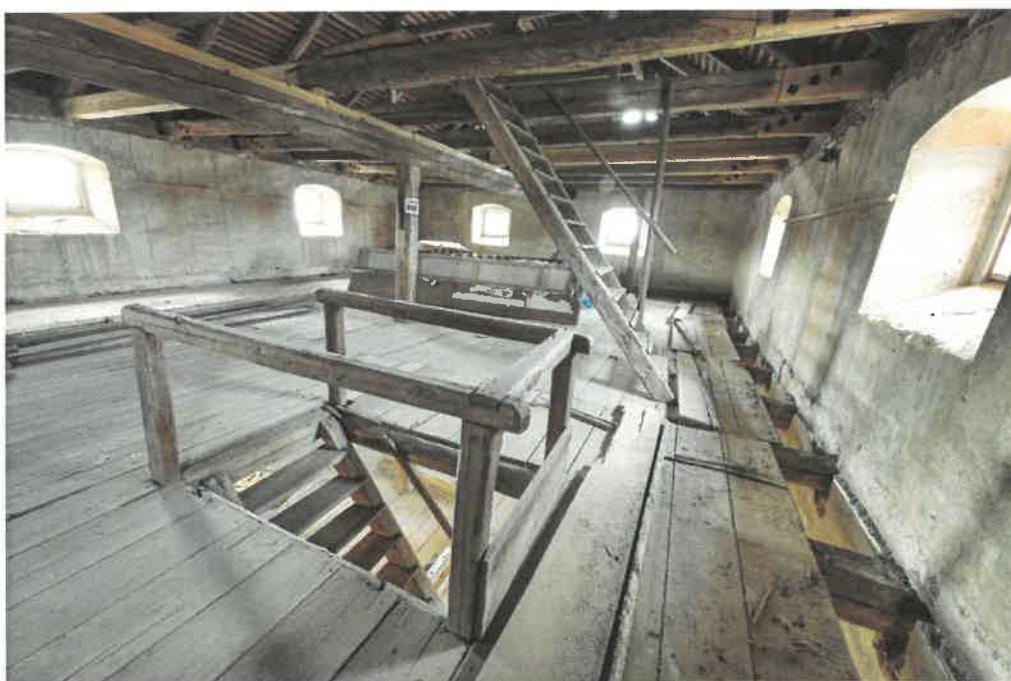
22. Prostor 3. nadzemního podlaží - pohled k severní části
