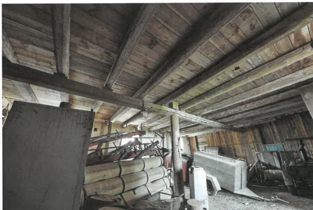
6. Prostor 1. nadzemního podlaží - pohled k severní části.
