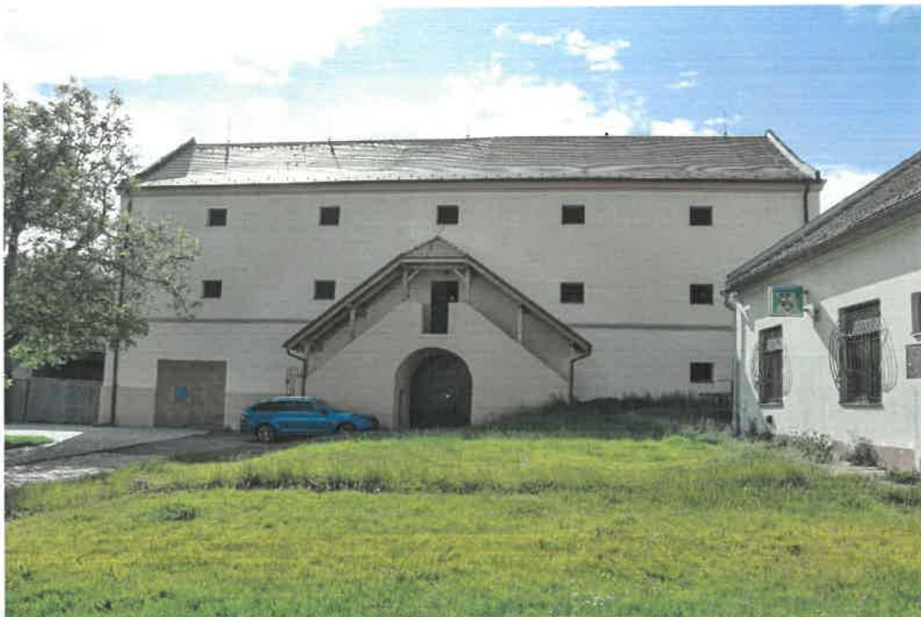
3. Pohled od východu.
