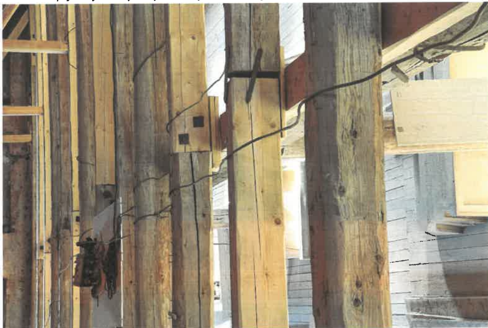
27. Napojení vyměněných a ponechaných částí vazných trámů krovu nad podélných průvlakem
