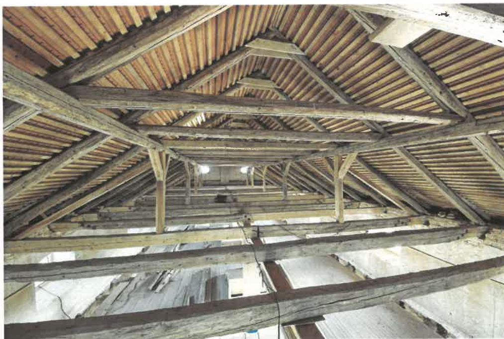
24. Konstrukce krovu
