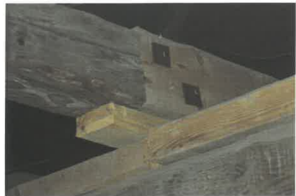
provedené opravy 3.NP
