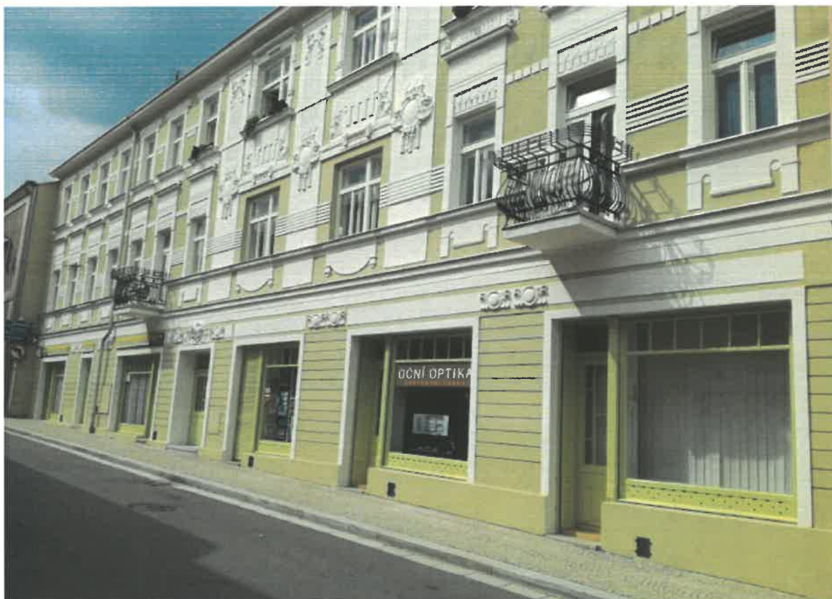
Průčelí městského domu čp. 71 po obnově v r. 2018:
