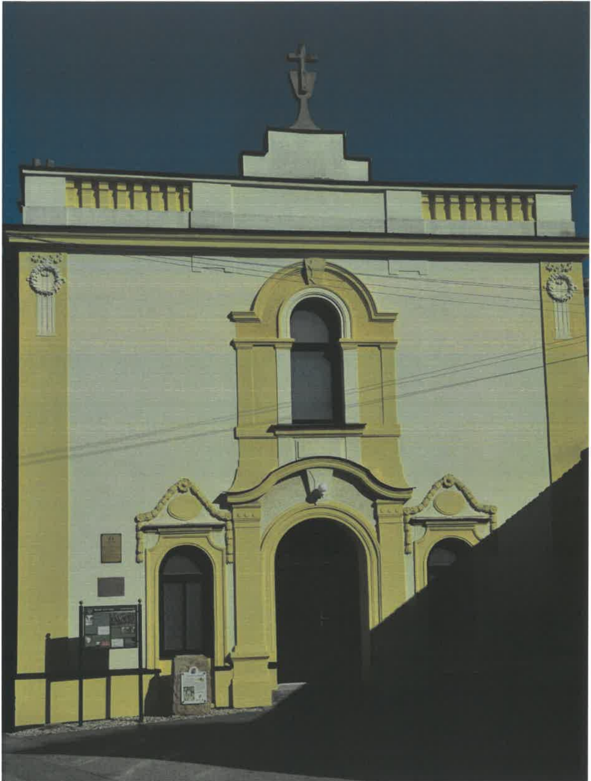
Synagoga, ul. Soudní (obnova "Desek desatera" na průčelí synagogy)
