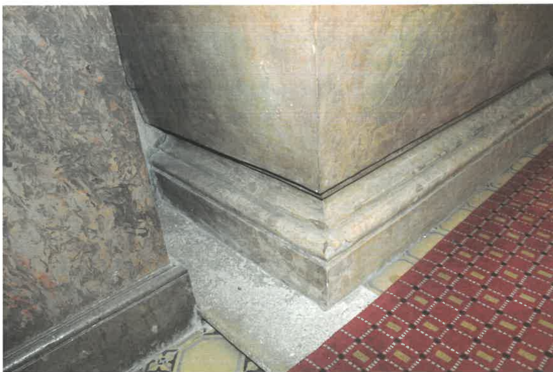
Restaurátorský průzkum - oltář sv. Kříže - nahore detail trhliny v místě spáry, dole oprava soklu u zdi
