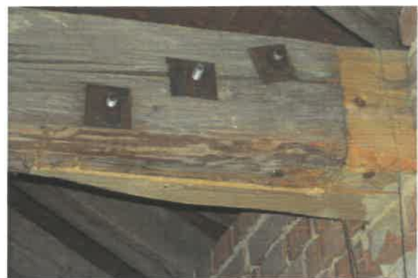
opravené zhlaví 3.NP
