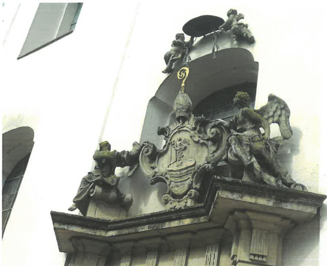
Fotografie před a po restaurování vstupního portálu v r. 2018:
