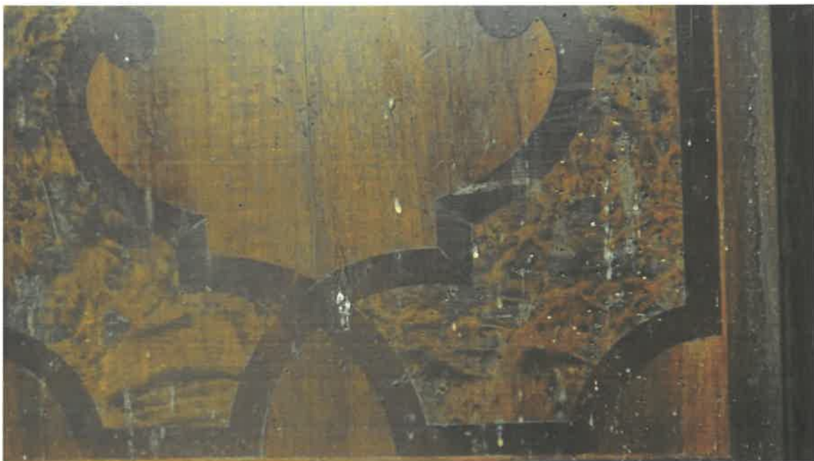
Detail poškození a opotřebení povrchové úpravy
