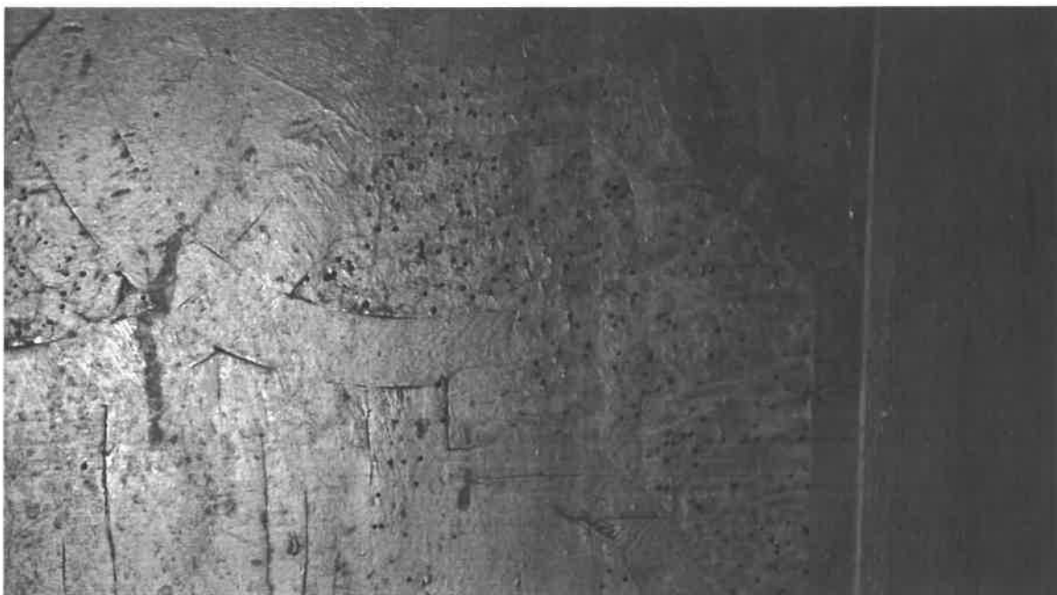
Poškození povrchové úpravy, patrné jsou výletové otvory dřevokazných škůdců
