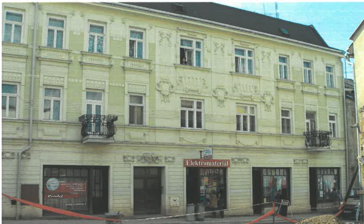
Průčelí městského domu čp. 71 před obnovou v r. 2017:
