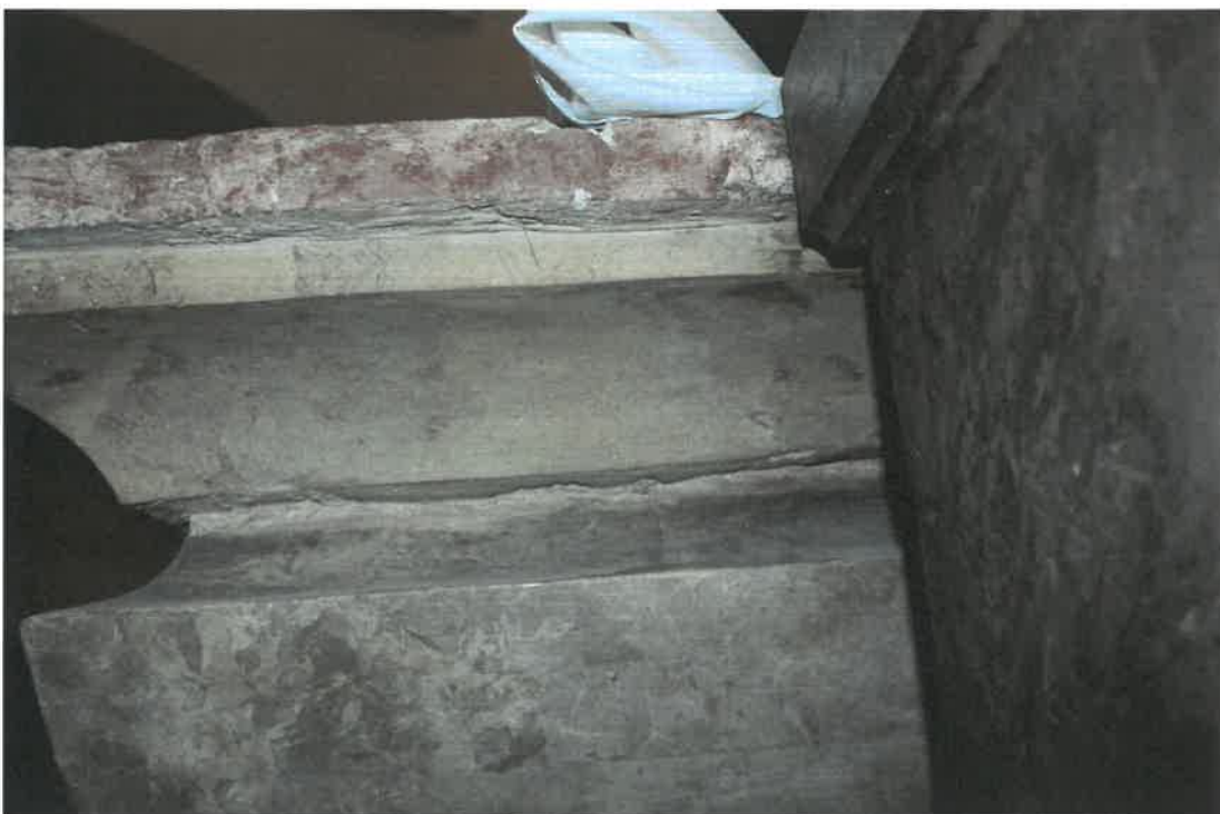
Restaurátorský průřez - oltář sv. Rodiny - nahoře prasklina podél horního bloku, dole pohled z boku vpravo
