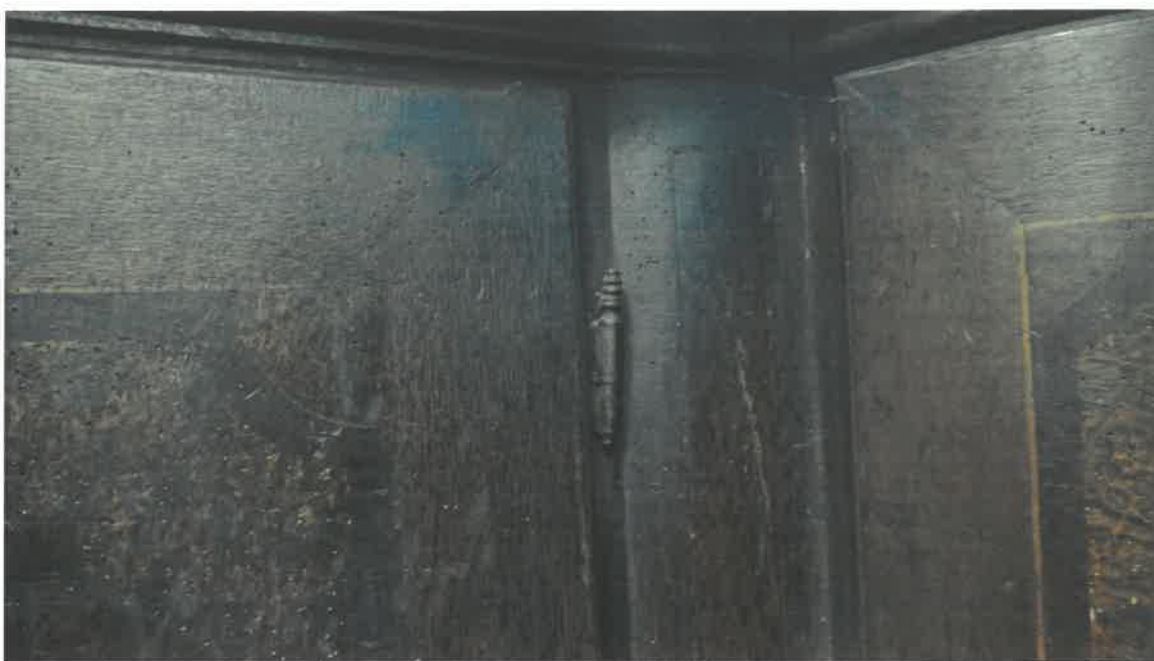
Detailní pohled na degradovanou povrchovou úpravu – stav před dílčí sondou povrchové úpravy
