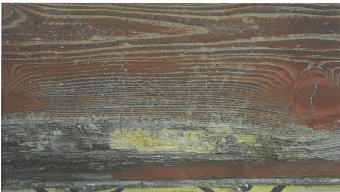
Detail poškození hrany stupňovitého podstavce vlivem dřevokazných škůdců
