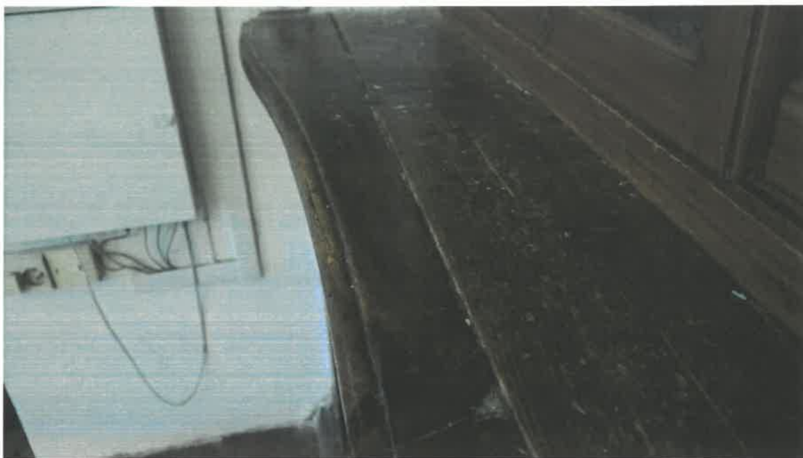
Detailní pohled na pultovou část – rozeschnutí jednotlivých dílců a poškození povrchové úpravy
