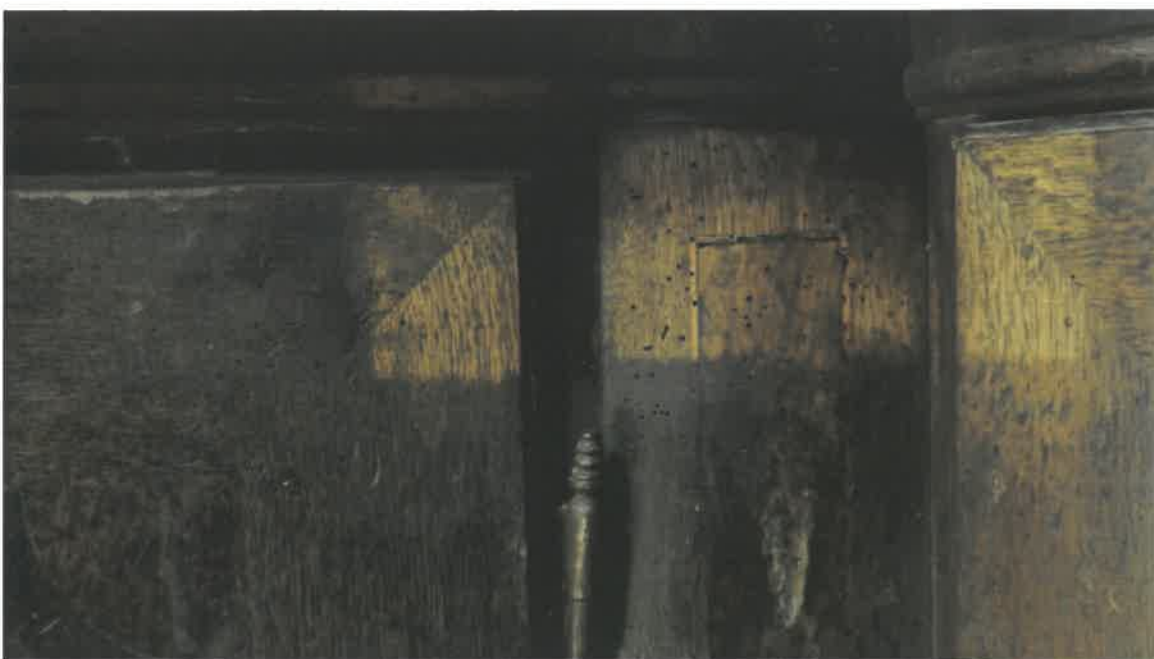
Detailní pohled na degradovanou povrchovou úpravu – stav po dílčí sondě povrchové úpravy
