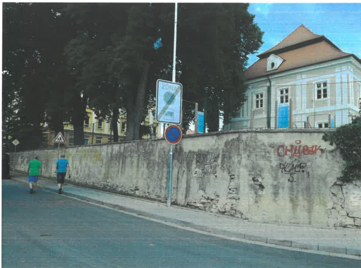
Opěrná zed' zámku před obnovou v r. 2019:
