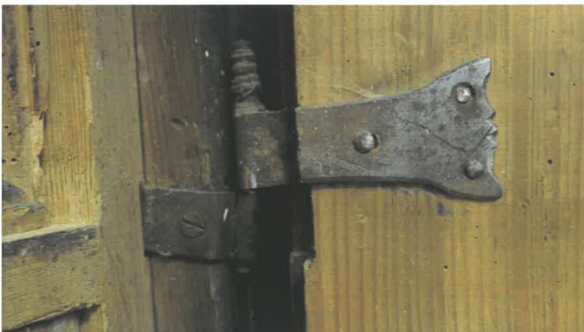
Detailní pohled na uvolnění křídlového pantu
