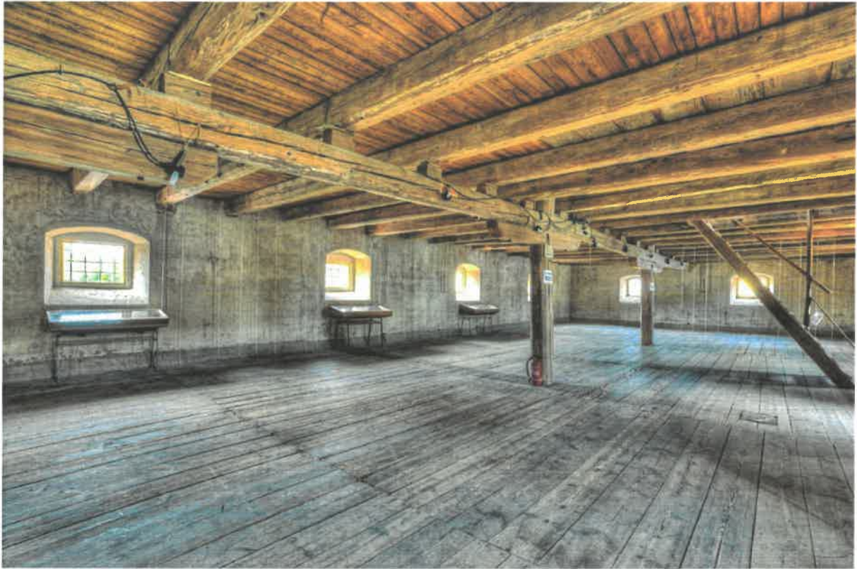
Bývalá sýpka, ul. K. H. Borovského (zajištění statiky nosných trámů a podlahy)
