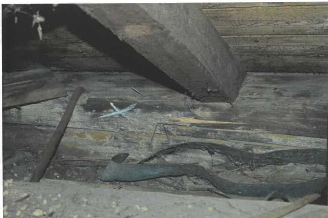
Obr. 8 Poškození pozednice dřevokaznou houbou ( Coniophora putina ).
