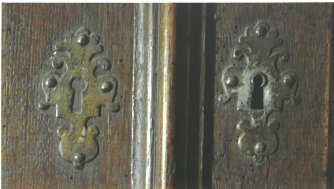
Detailní pohled na poškození klíčových štítků
