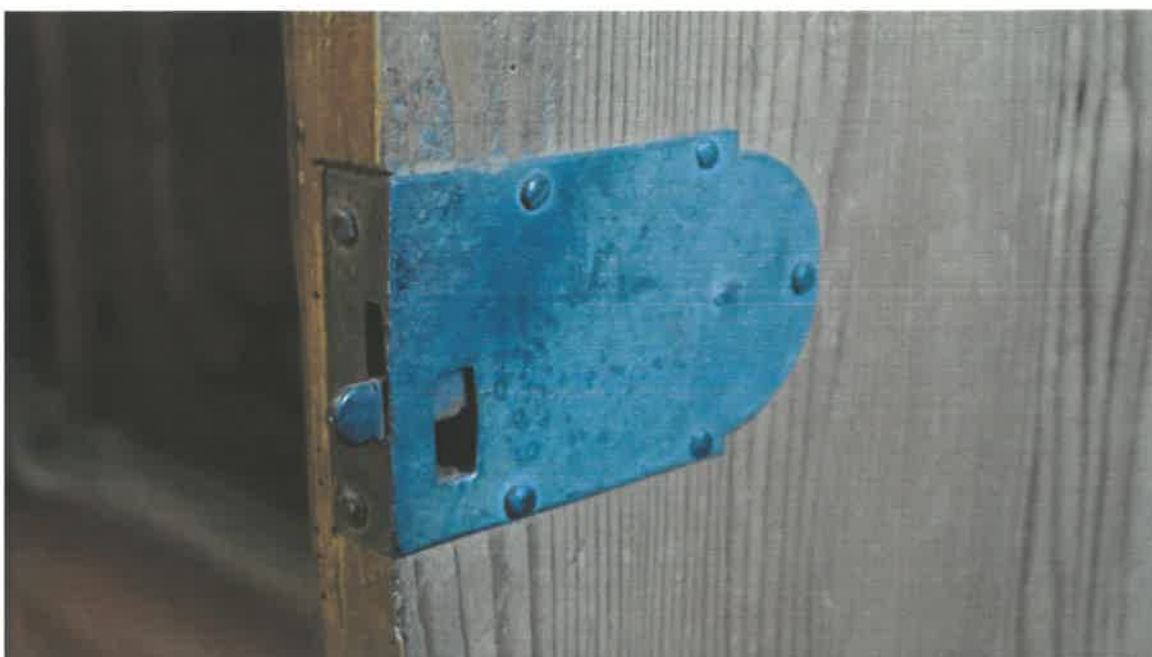
Detailní pohled na mechanickou západku
