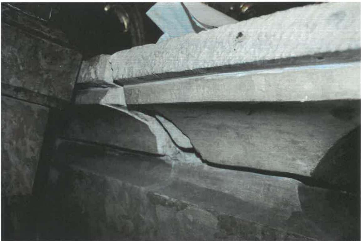
Restaurátorský průzkum - oltář Nanebevzetí P. Marie - nahoře chybějící část mramoru na soklu vlevo, dole poškození mramoru v místě spáry mezi bloky kamene.
