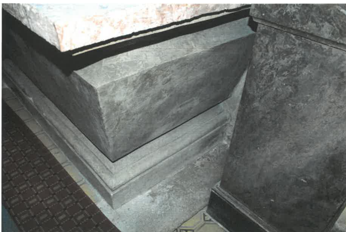
Restaurátorský průzkum - oltář sv. Rodiny - nahoře oprava velké plochy u zdi vlevo, dole poškrabaná plocha tumby vpravo
