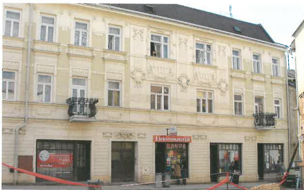
Průčelí městského domu čp. 71 před obnovou v roce 2017:
