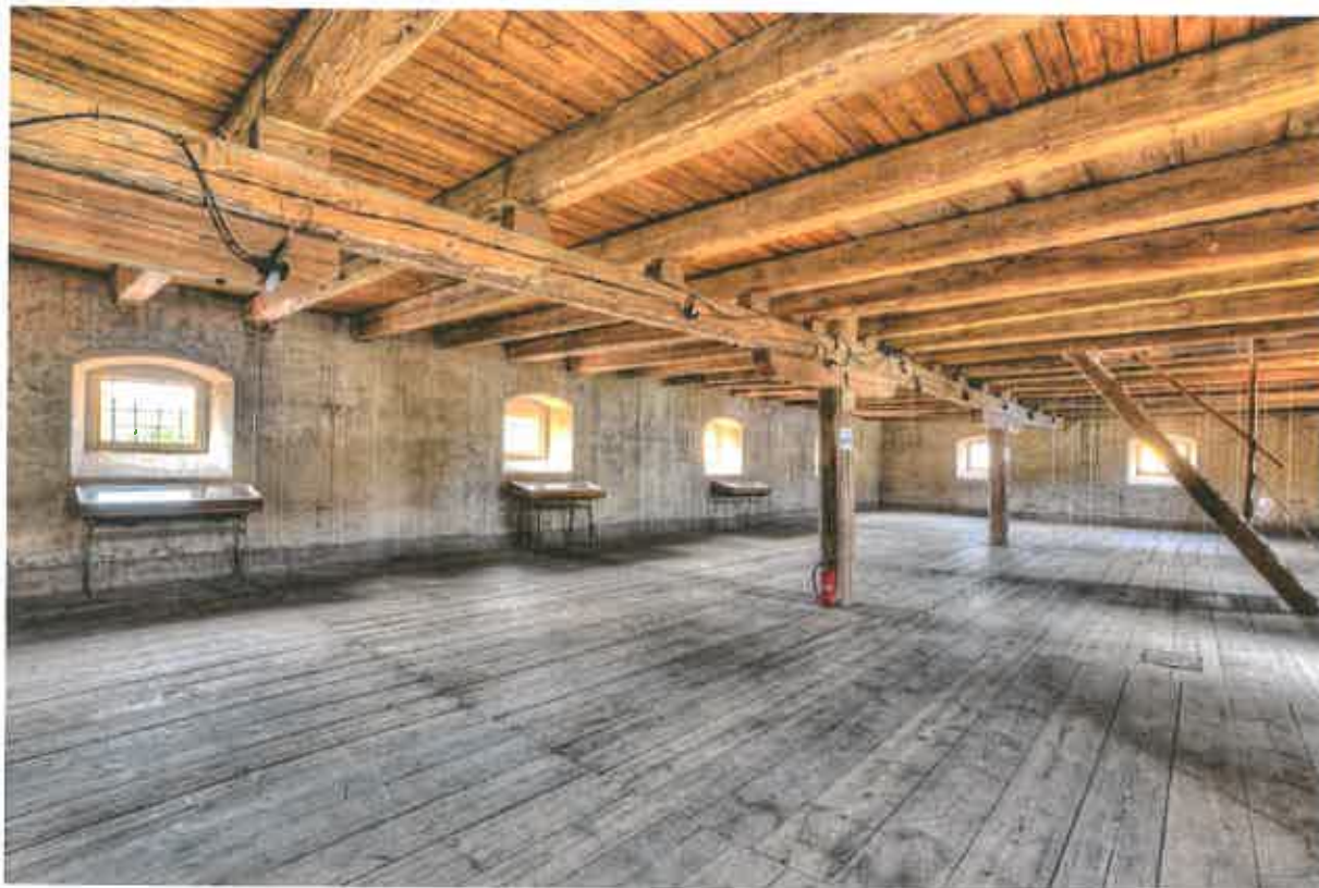
Bývalá sýpka, ul. K. H. Borovského (zajištění statiky nosných trámů a podlahy)
