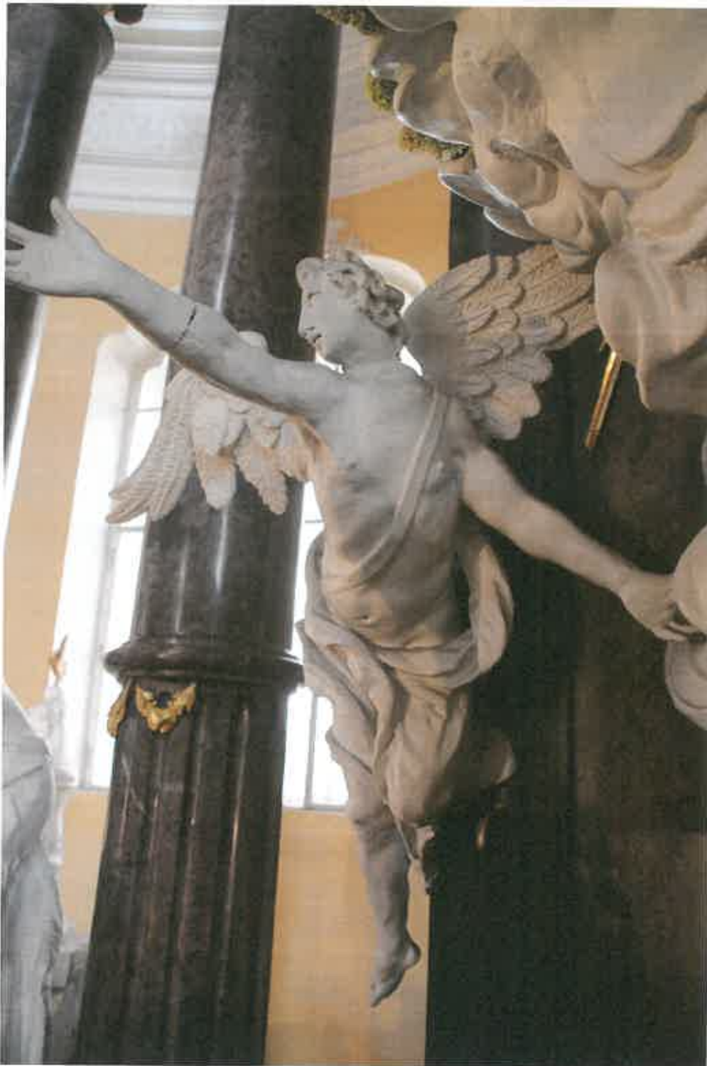
Detail levého anděla s prasklinou na pravé ruce
