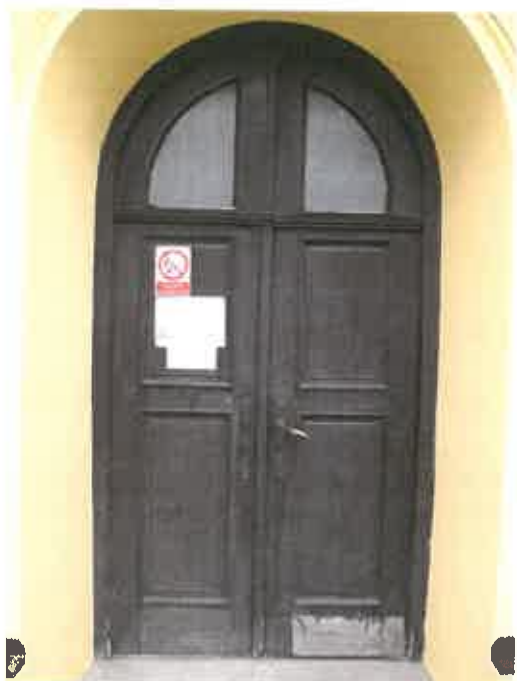
Fotografie po výměně vchodových dveří v r. 2013:
