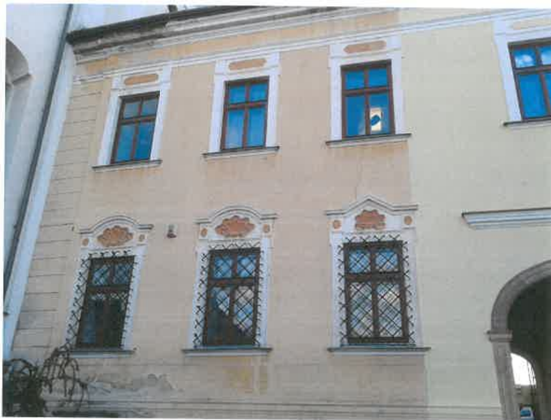
Církevní část prelatury před a po obnově fasády v roce 2017:
