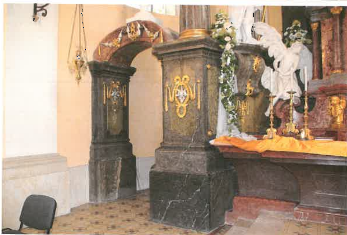
Celkový pohled na pravý a levý portál.
