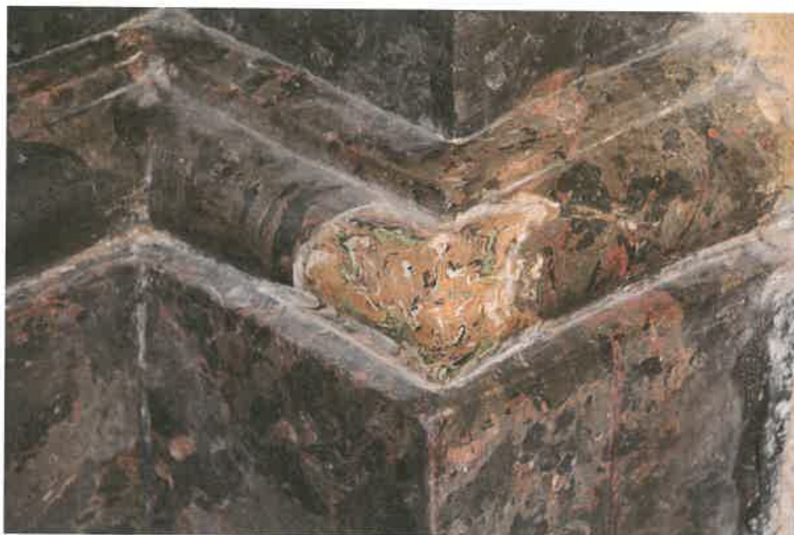
Nahoře neodborné doplnění profilované římsy. Dole doplnění rohu v umělém mramoru s barevnou odlišností.
