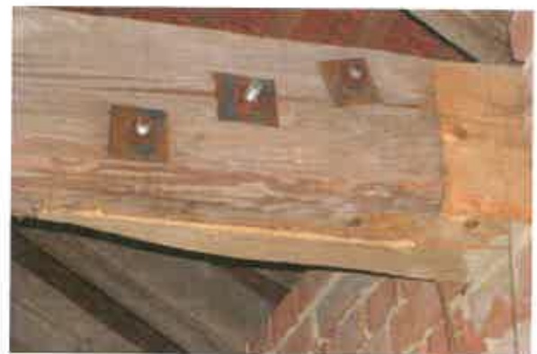
opravené zhlaví 3.NP
