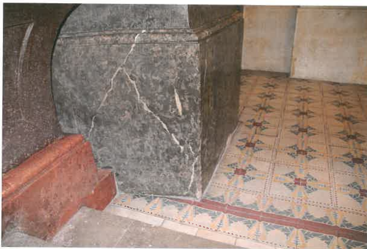
Nahoře detail soklové části v pravo, s odpadlou větší plochou umělého mramoru. Dole detail napojení menzy na podstavec s portálem vpravo.
