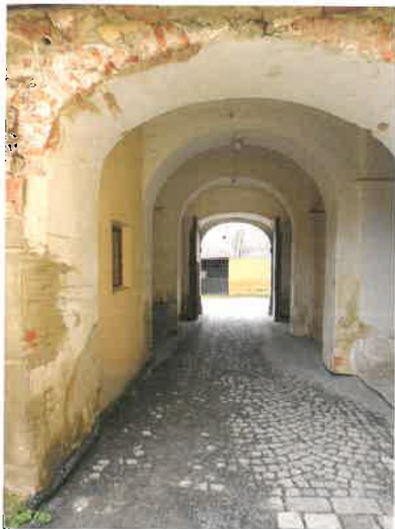
Průjezd do dvorního traktu před a po obnově v r. 2014:
