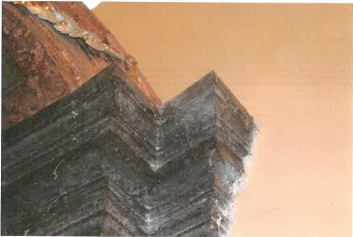
Nahoře neodborný sádrový doplněk u levého portálu. Dole detail zašpinění barvou u zdi.
