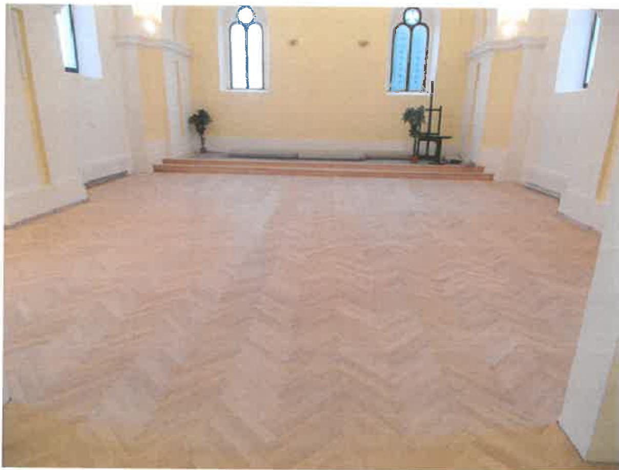
Fotografie po výměně podlahy v synagoze v r. 2012:
