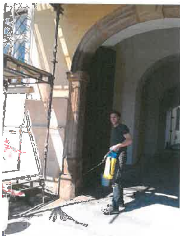
Restaurování vjezdového portálu v r. 2016:
