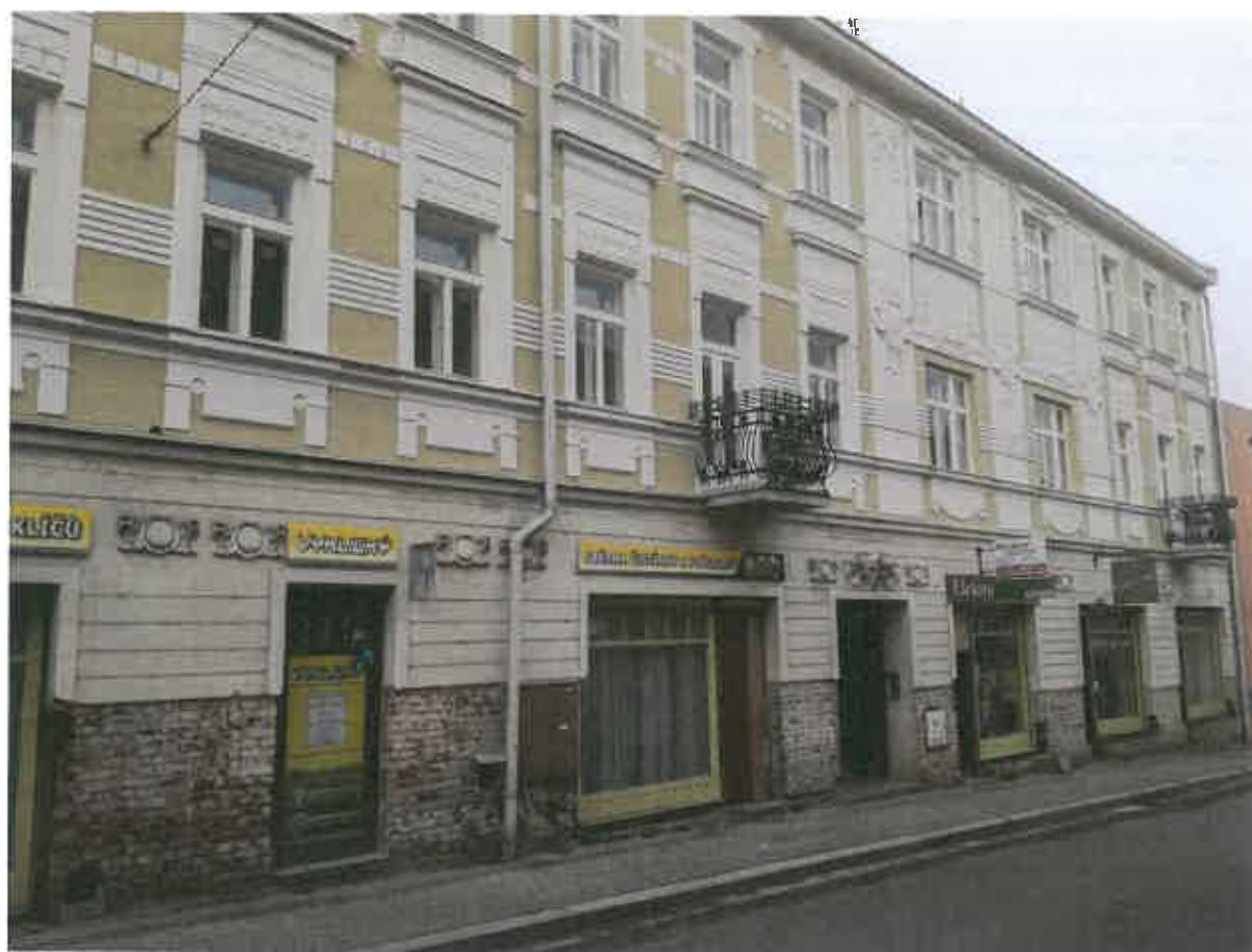
Průčelí městského domu čp. 71 po obnově v roce 2017:
