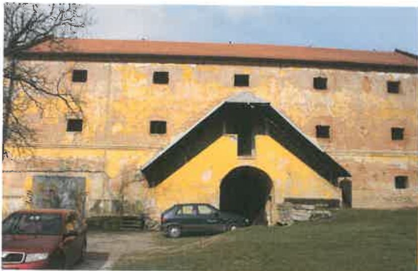
Sýpka před (s vyměněnou střešní krytinou z r. 2010) a po obnově v roce 2015:
