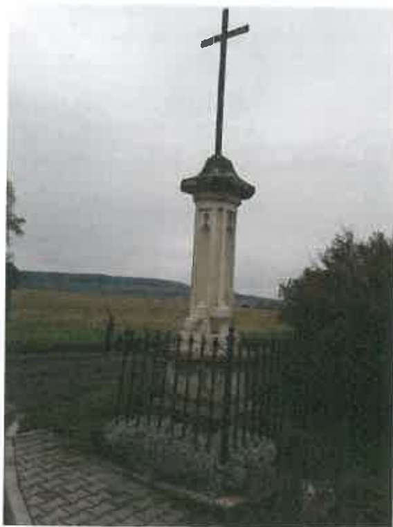
d) Obnova kříže na ulici Horní – stav před a po obnově:
