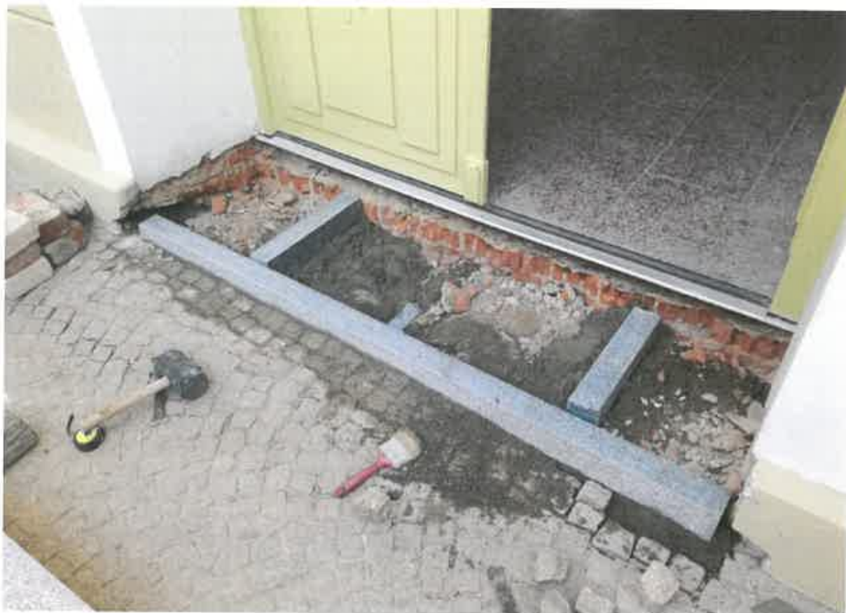
Fotografie z realizace obnovy soklové části fasády domu čp. 71 v roce 2018:
