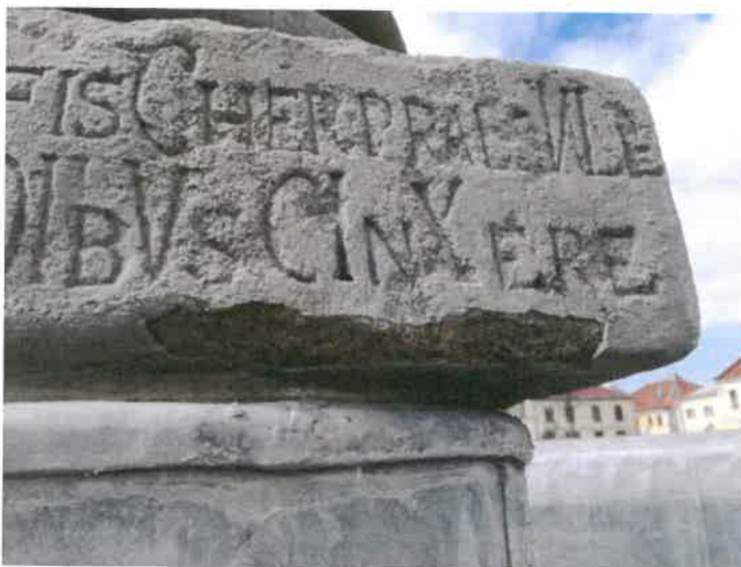
JEVIČKO - KAŠNA , STŘEDOVÝ PILÍŘ S AMORKEM, DOKUMENTACE SOUČASNÉHO STAVU
