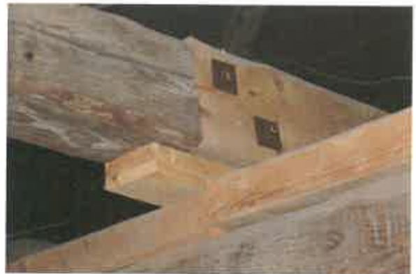
provedené opravy 3.NP
