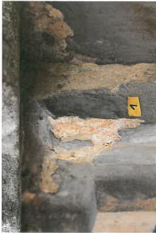
JEVIČKO – ROKOKOVÝ KŘÍŽ – spodní díl podstavce, rozpad horniny vlivem zasetení, tmavá křusta na kamenné
