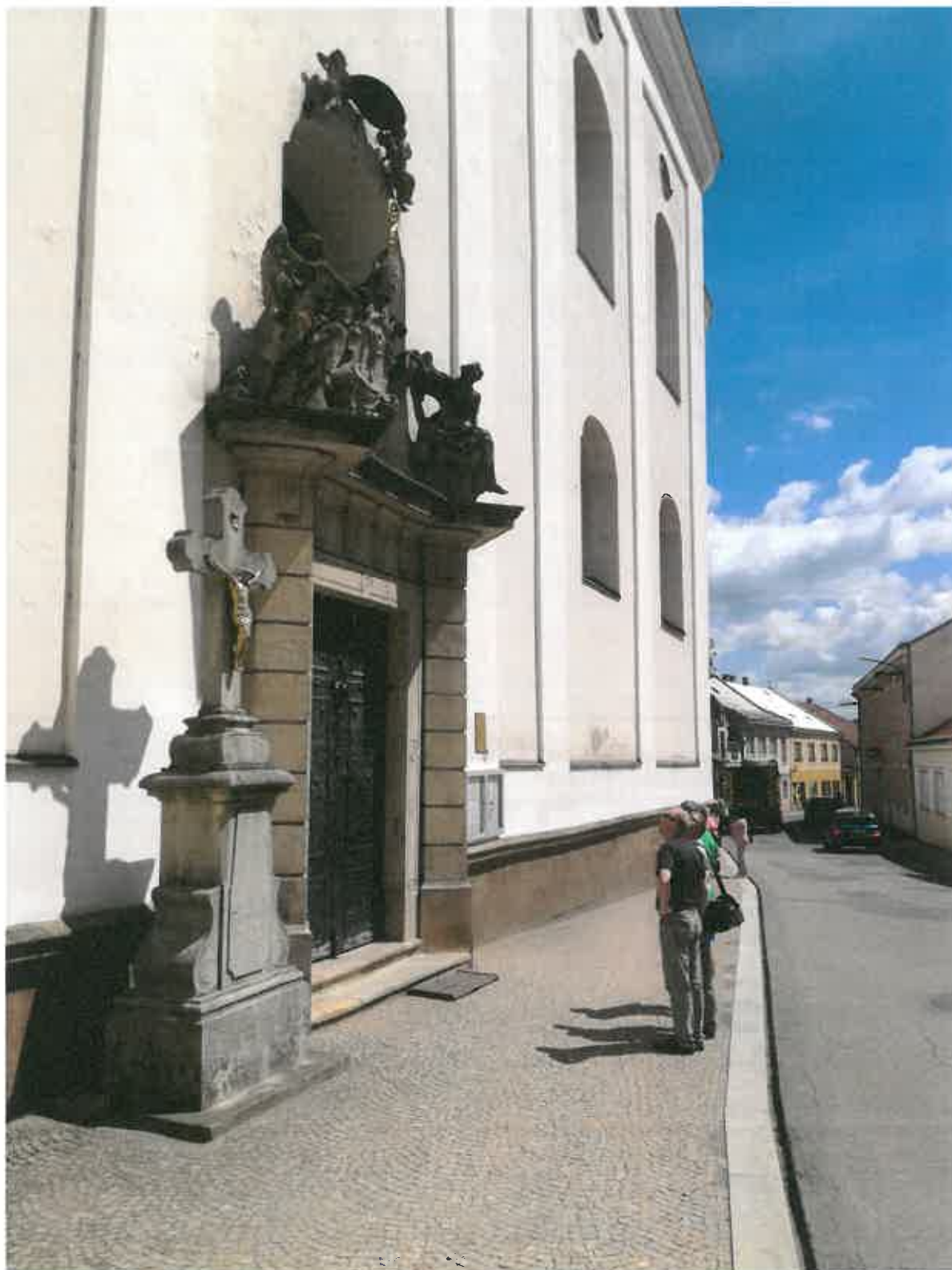
Kostel Nanebevzetí Panny Marie, ul. Kostelní (restaurování kamenného kříže vedle portálu)
