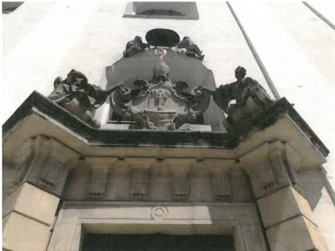
Kostel Nanebevzetí Panny Marie, ul. Kostelní (restaurování sochařské výzdoby portálu)
