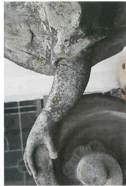
JEVIČKO – PORTÁL, PRAVÝ ANDĚL, ROZPRASKANÉ UKONČENÍ VOLUTY NA PODSTAVCI, ŠTUKOVÁ NÁHRADA
