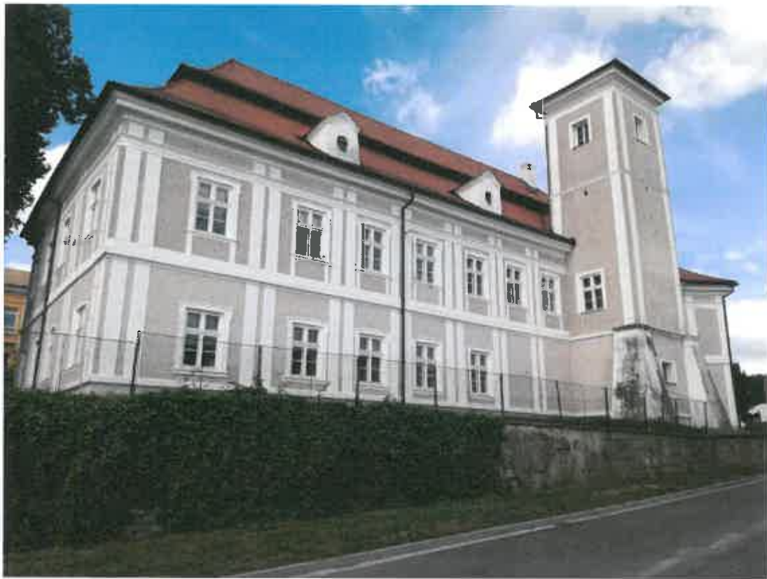
Zámek, ul. U Zámečku (oprava a statické zajištění opěrné zdi)
