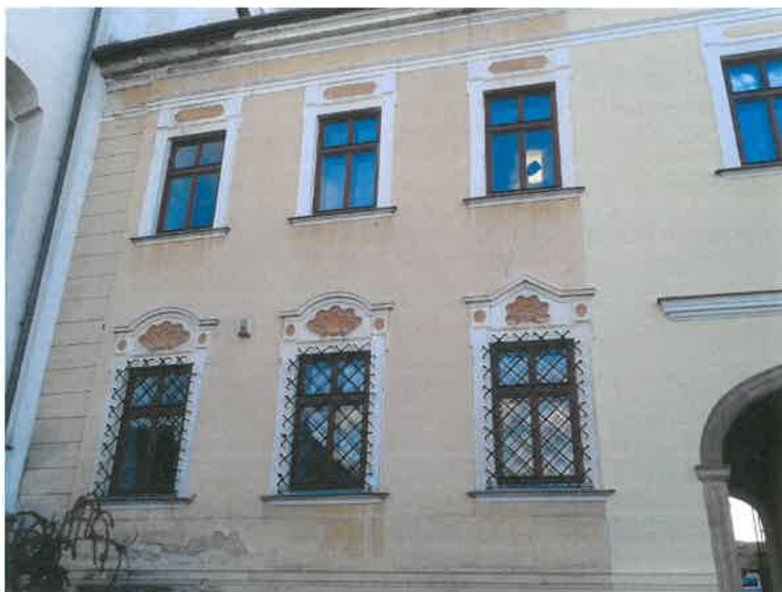
Církevní část prelatury před a po obnově fasády v roce 2017:
