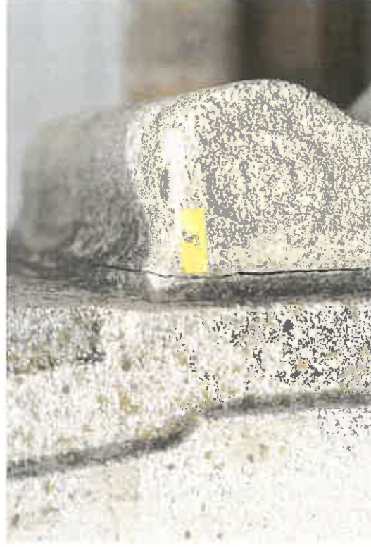
JEVIČKO – KAMENNÝ KRÍŽ – spára mezi pravou volutou a podstavcem, delaminace hmoty
