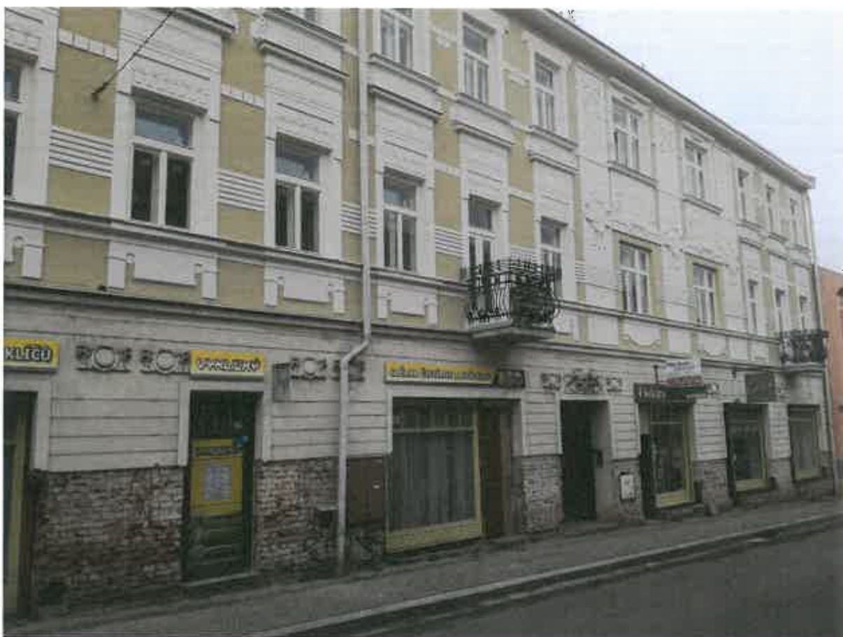
Průčelí městského domu čp. 71 před obnovou v roce 2017:
