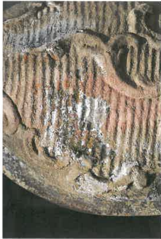
JEVÍČKO – PORTÁL, MITRA, PORUCHY V POVRCHU, ODPADÁVAJÍCÍ BARVA
