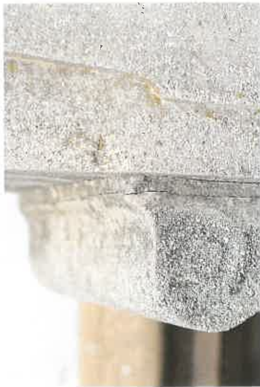
JEVIČKO – KAMENNÝ KŘÍŽ – spára mezi pravou volutou a podstavcem, delaminace hmoty
