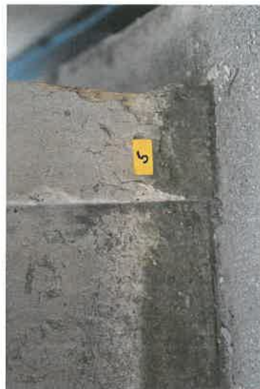
JEVIČKO – ROKOKOVÝ KŘÍŽ – spodní díl podstavce, rozpad horniny vlivem zasetení, biologické nálety (fasy a bakterie)
