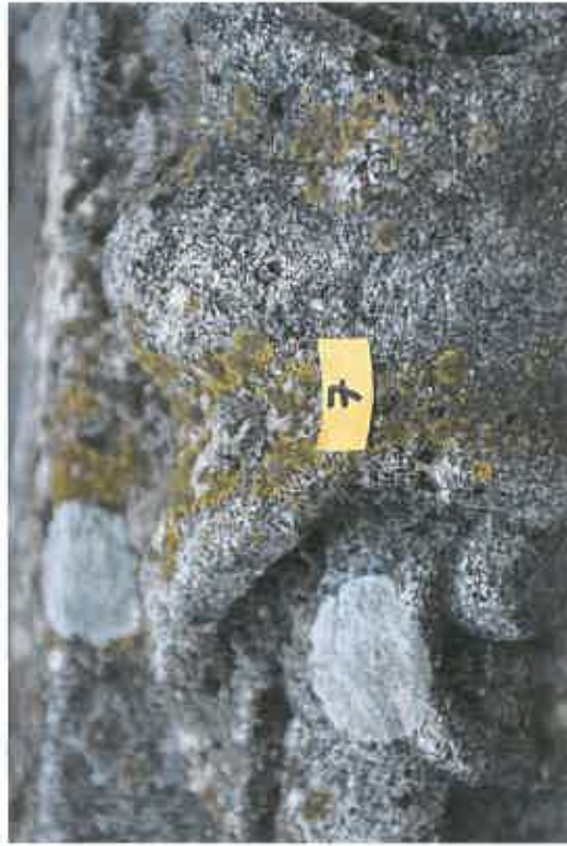
JEVIČKO – ROKOKOVÝ KŘÍŽ – horní díl podstavce, defekty ve hmotě kamene, biologické kultury na povrchu - lišejníky
