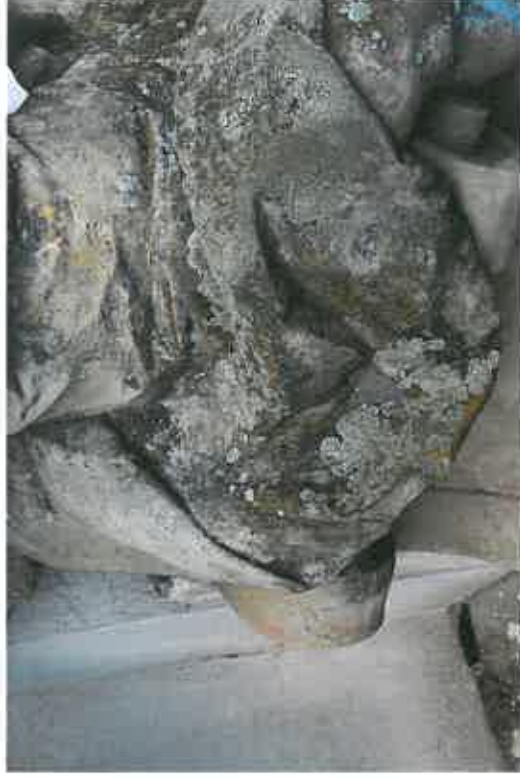
JEVIČKO – PORTÁL, PRAVÝ ANDĚL, TRHLINY V DRAPERII, NEČISTOTY, MECHY
