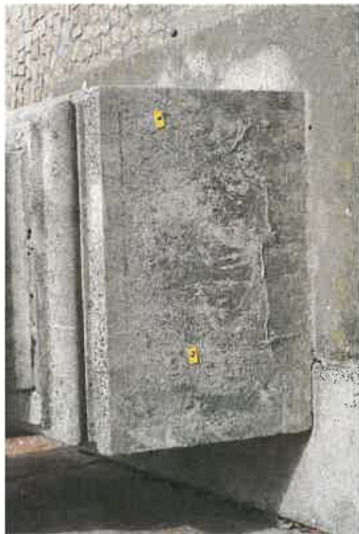
JEVIČKO – ROKOKOVÝ KŘÍŽ – horní díl podstavce, defekty ve hmotě kamene, biologické kultury na povrchu – lišejníky (1c + 1d)
