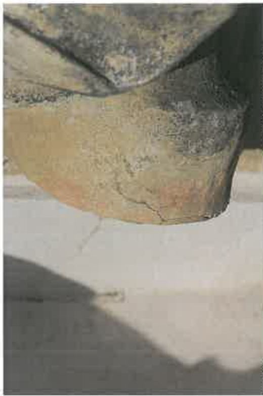
JEVIČKO – PORTÁL, PRAVÝ ANDĚL, ROZPRASKANÉ UKONČENÍ VOLUTY NA PODSTAVCI, ŠTUKOVÁ NÁHRADA
