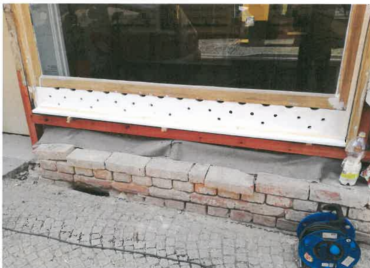
Fotografie z restaurování výkladců na domě čp. 71 v roce 2017:
