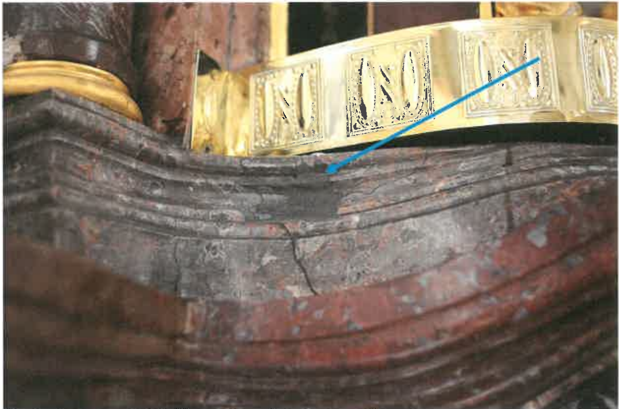
Materiálové a tvarové nevhodné doplnky, značne popraskaná skorepina umětieho mramoru
