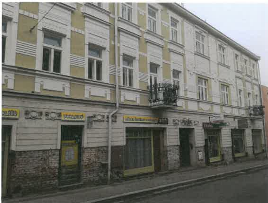
Průčelí městského domu čp. 71, ul. Třebovská (obnova fasády – soklová část)
