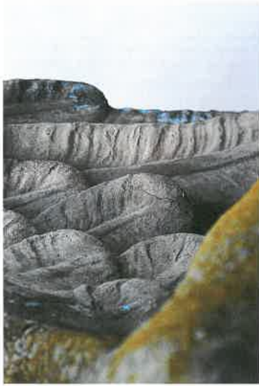
JEVIČKO – PORTÁL, PRAVÝ ANDĚL, ROZPRASKANÉ KONCE KŘÍDEL, ŠTUKOVÁ NÁHRADA
