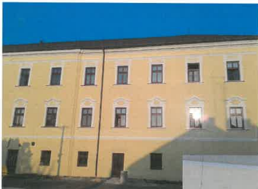
Prelatura po obnově východního a západního křídla v r. 2016:
