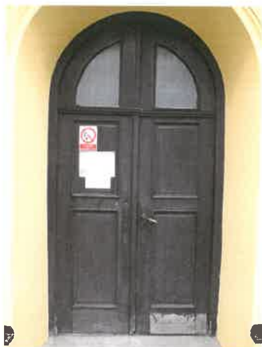
Fotografie po výměně vchodových dveří v r. 2013:
