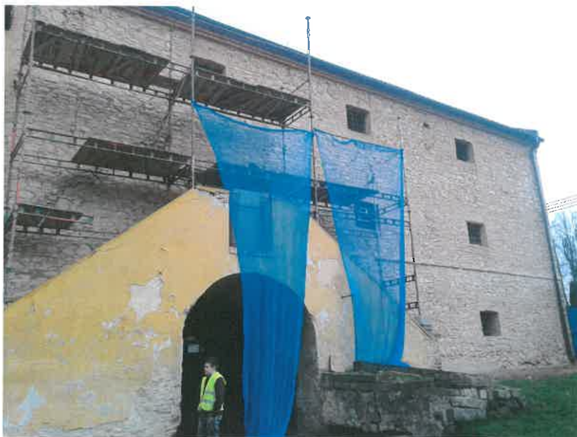
Realizace opravy omítek a střechy nad schodištěm v r. 2015:
