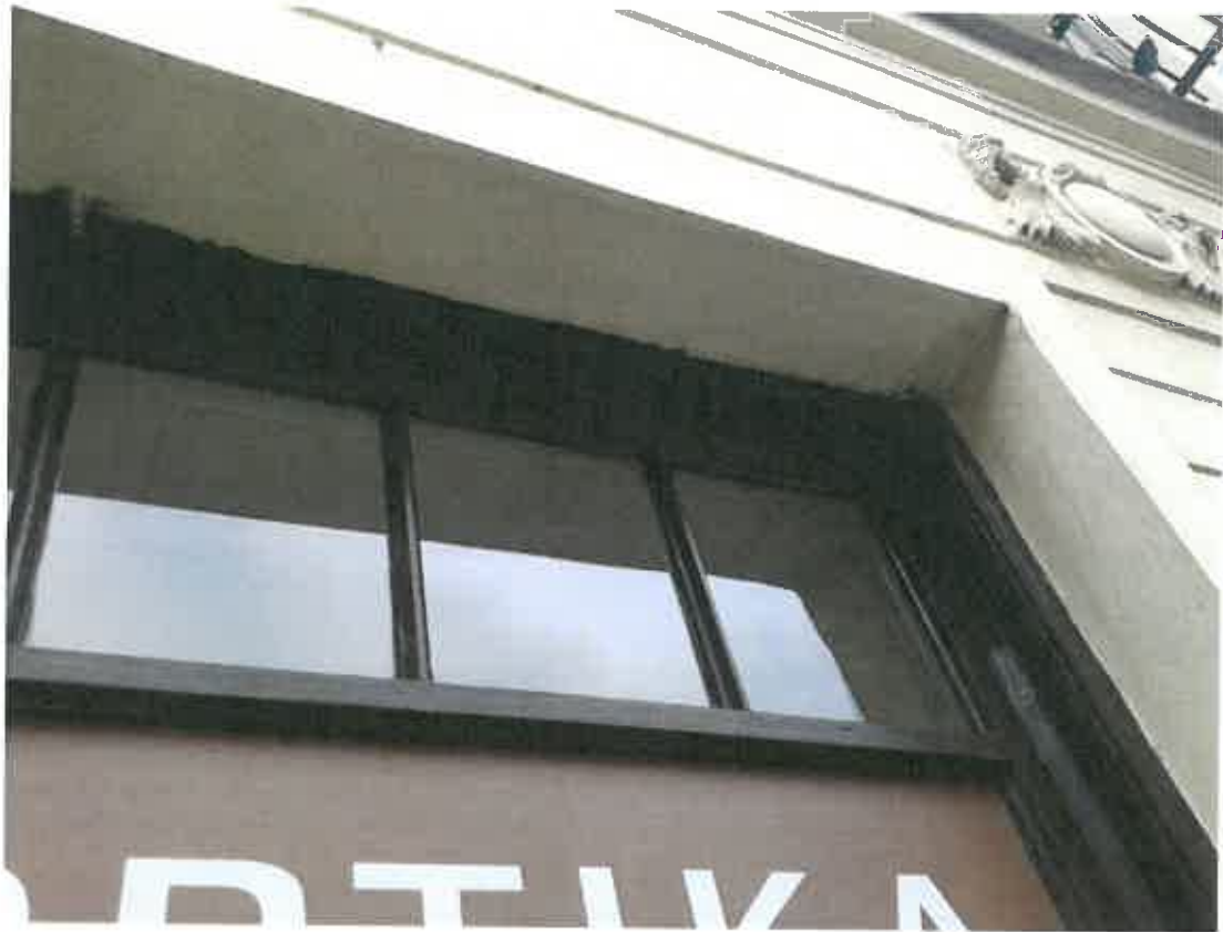
Průčelí městského domu čp. 71, ul. Třebovská (původní výkladec)
