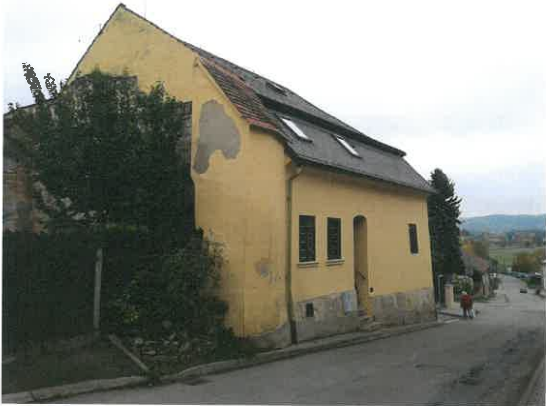
Městský dům čp. 224, ul. Olomoucká (obnova pískovcového soklu)
