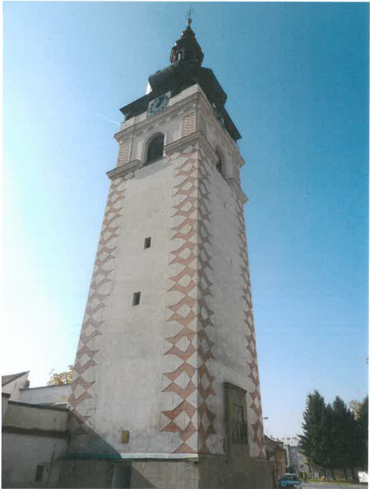
Městská věž, Komenského náměstí (obnova venkovního pláště, restaur. práce sgrafita – psanička)
