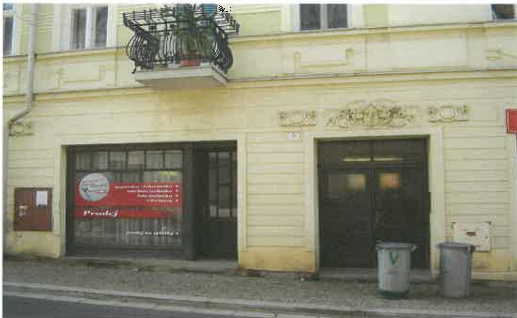
Průčelí městského domu čp. 71, ul. Třebovská (odsanování soklové a nadsoklové části, obnova fasády bosáže, výměna dřevěných otvorových prvků včetně vstupních vrat - nevhodný zásah v 80. letech)
