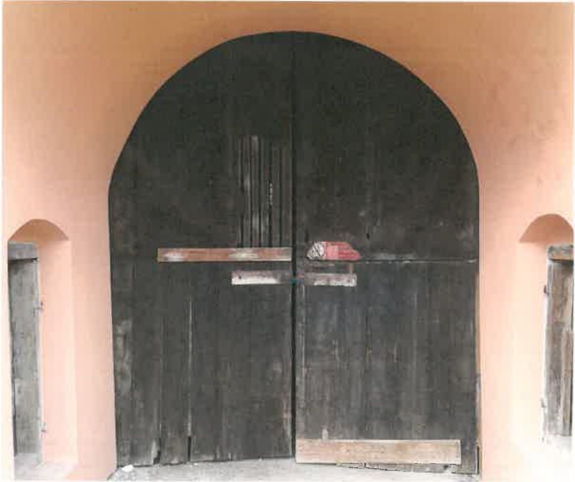
Sýpka, ul. K. H. Borovského (obnova 1ks vrat a 2 ks dvířek pod schodištěm)
