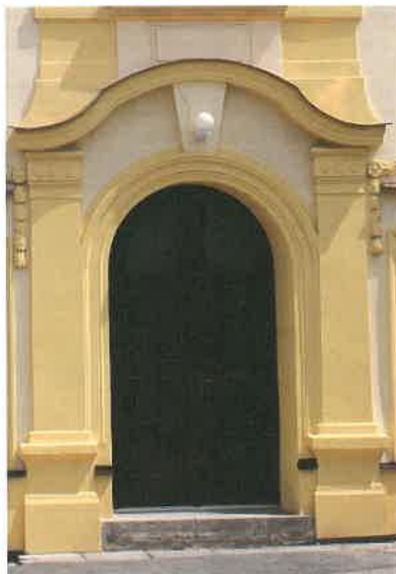
Fotografie po výměně vchodových dveří:
