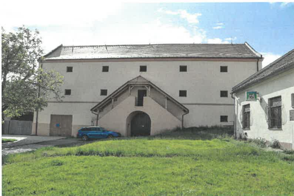
3. Pohled od východu.
