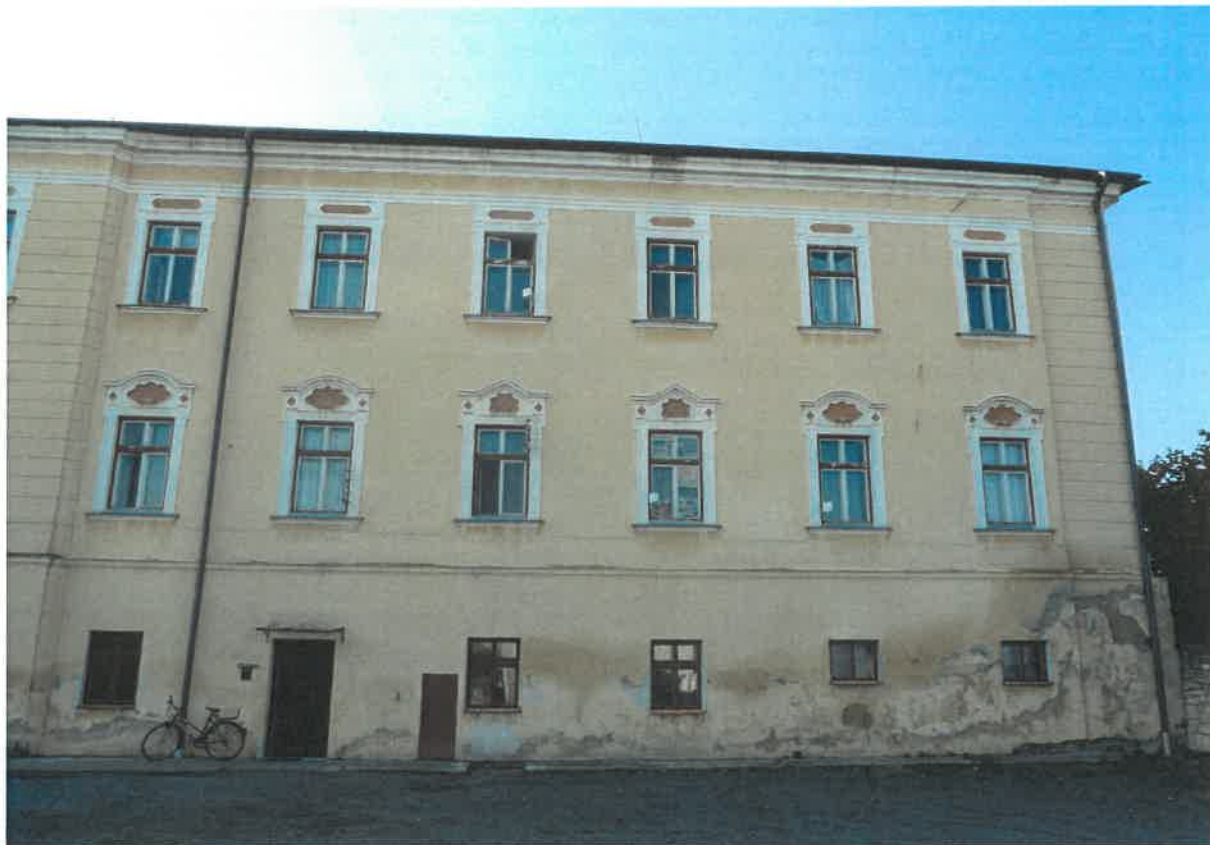
Prelatura bývalého augustiniánského kláštera před a po obnově soklové části omítky (vč. výměny otvorových prvků, 2012 – 2013):
