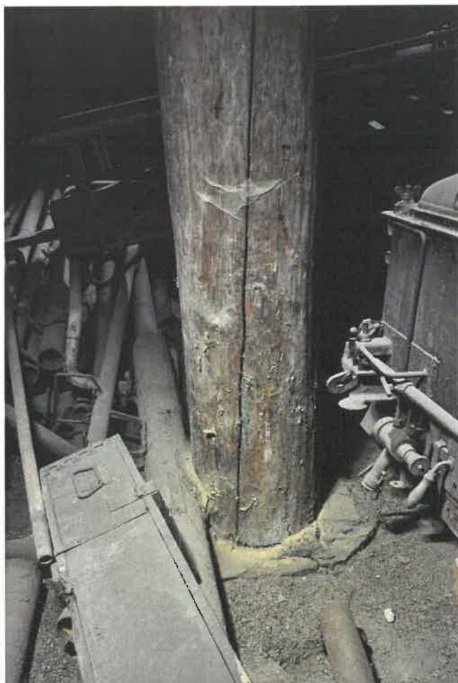
9. Spodní část jižního sloupu v 1. NP silně aktivně napadená červotočem.
