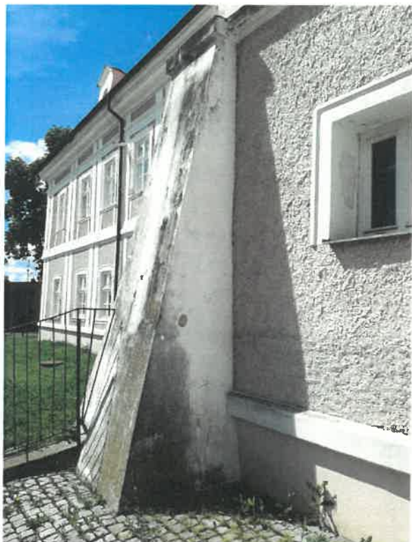
Pilíře věže zámku před a po obnově v r. 2019:
