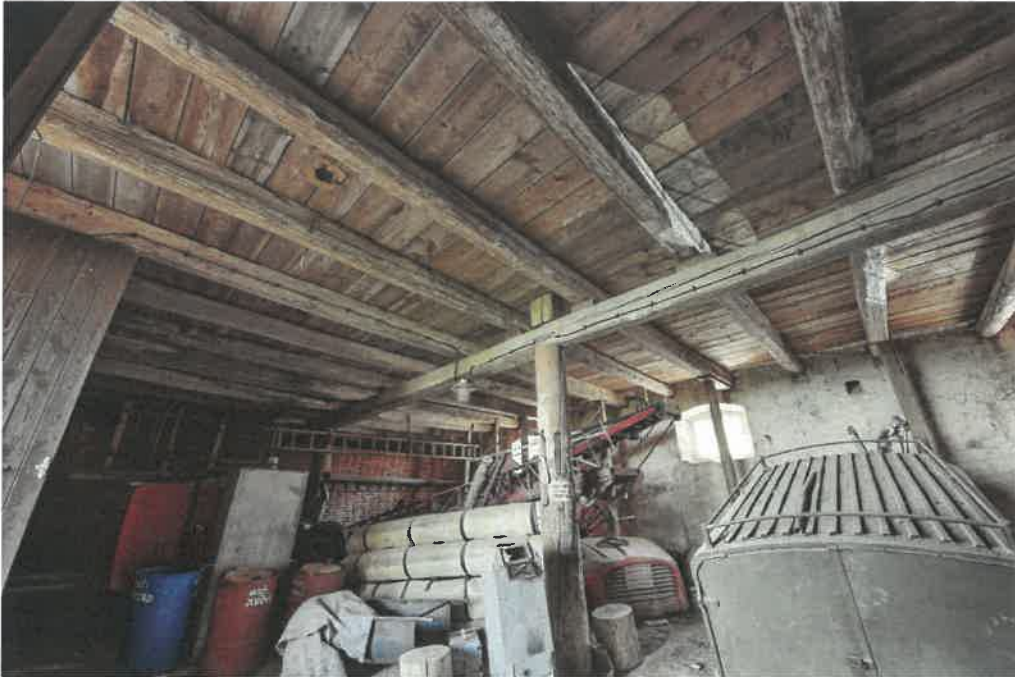
5. Prostor 1. nadzemního podlaží - pohled k severní části.
