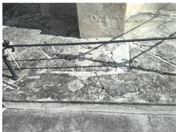
Výměna dlažby a vnitřních schodů kolem sochy sv. Jana Nepomuckého v r. 2018:
