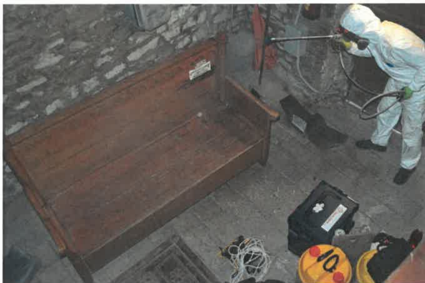
Fotografie z realizace chemického ošetření městské věže v r. 2020:
