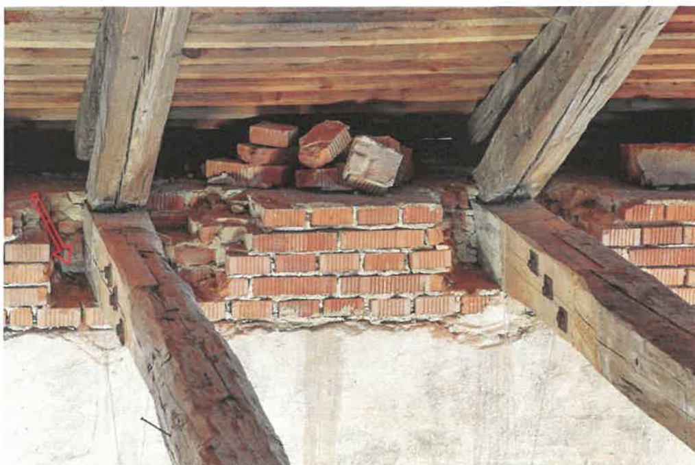
26. Detail odsekání zhlaví vazných trámů. Šipkou vyznačena poloha zcela zazděné pozednice, instalované pod vaznými trámy
