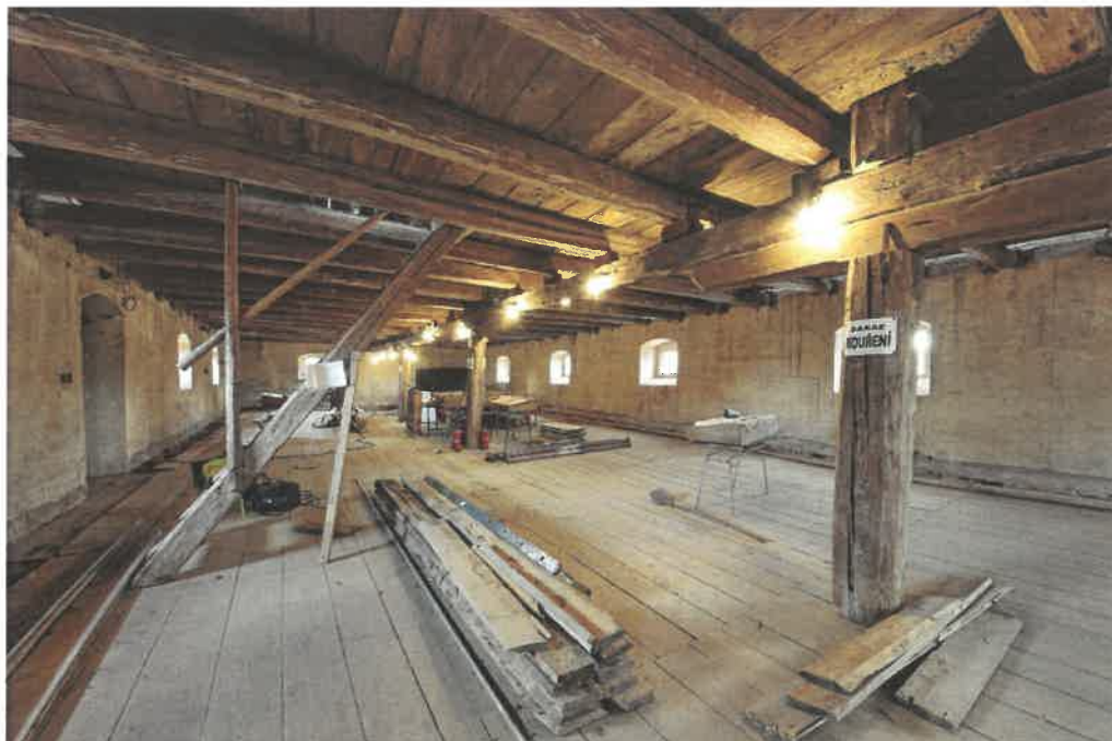
13. Prostor 2. nadzemního podlaží - pohled k jižní části.
