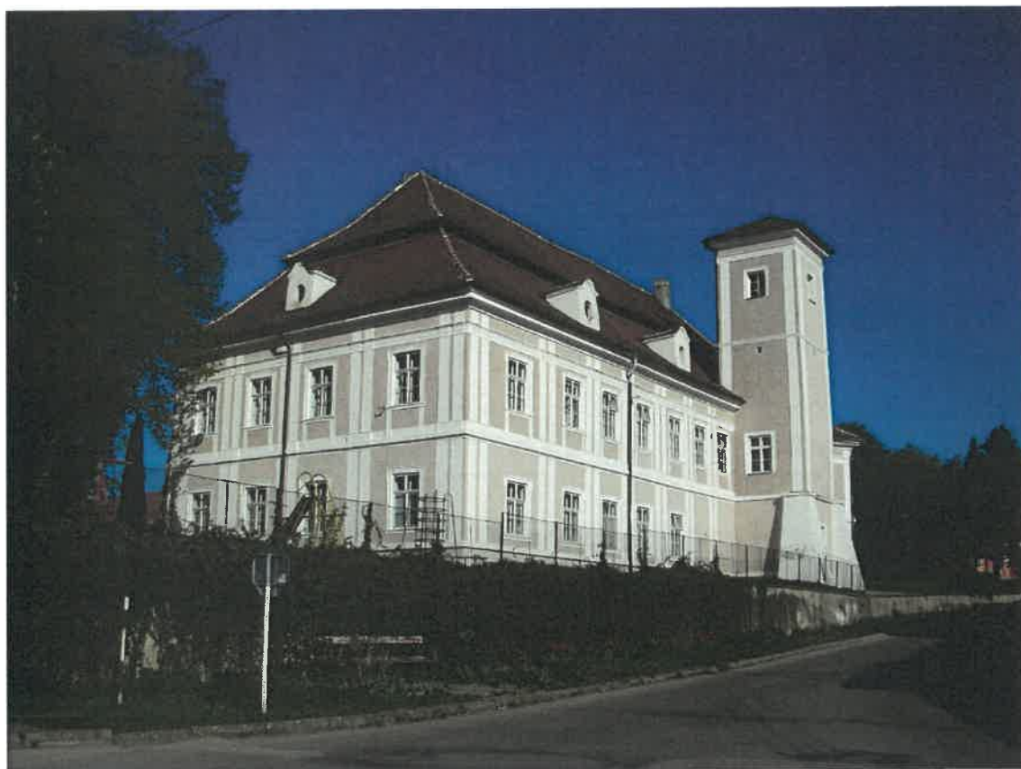
Zámek před a po realizaci akcí obnovy v r. 2009:
