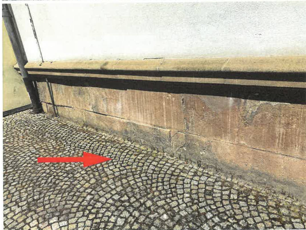
Pohled na levou stranu kamenné podezdívky s hmotnou průběžnou římsou z umělého kamene. V rohu sousedí s Muzeem je 1. svod zapuštěný do chodníku. Tmavé mapy podél chodníku svědčí o zamokření v době dešťových srážek. Voda stékající z korunní římsy vymývá štěrk ze spár dlažebních kostek.
