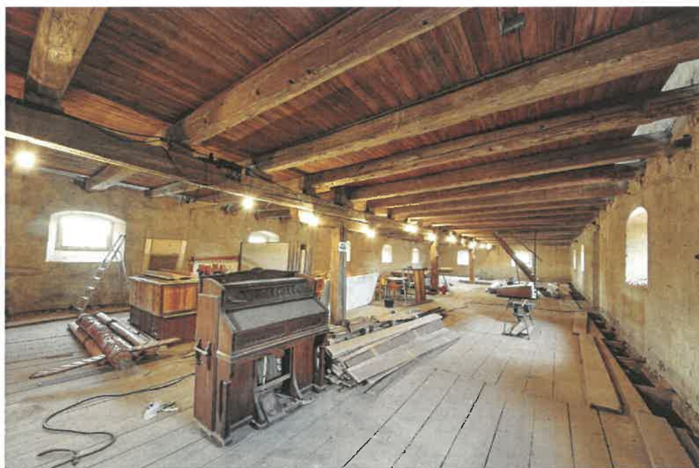
14. Prostor 2. nadzemního podlaží - pohled k severní části
