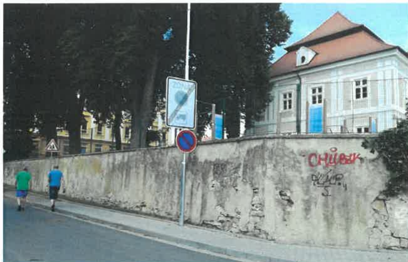
Opěrná zeď zámku před a po obnově v r. 2019:
