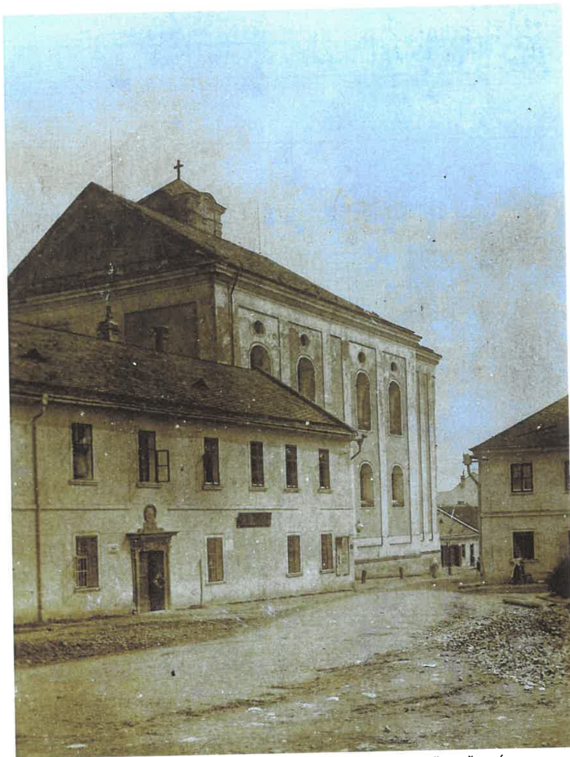
Dobová fotografie - původní prašná cesta je o cca 40 cm níže než současná vozovka. Na rohu kostela je viditelná postava, která je nižší než kamenný obklad
