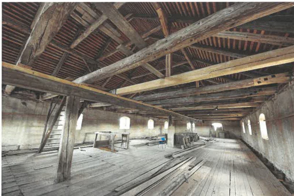
21. Prostor 3. nadzemního podlaží - pohled k jižní části
