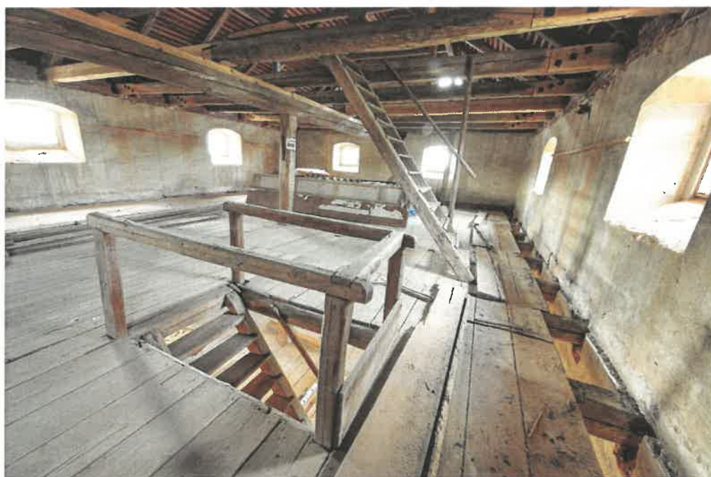
22. Prostor 3. nadzemního podlaží - pohled k severní části
