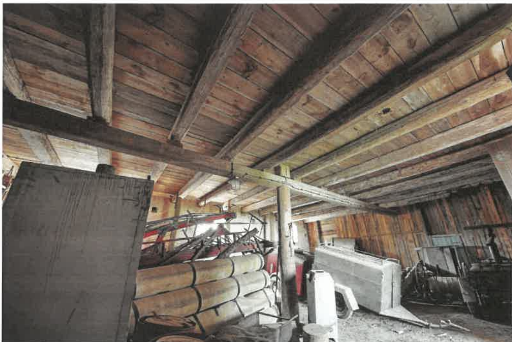
6. Prostor 1. nadzemního podlaží - pohled k severní části.
