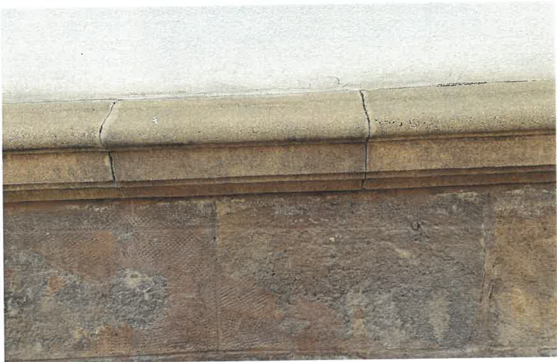
Nahoře vysunuté kamenné desky. Dole chybějící spárování průběžné římsy.
