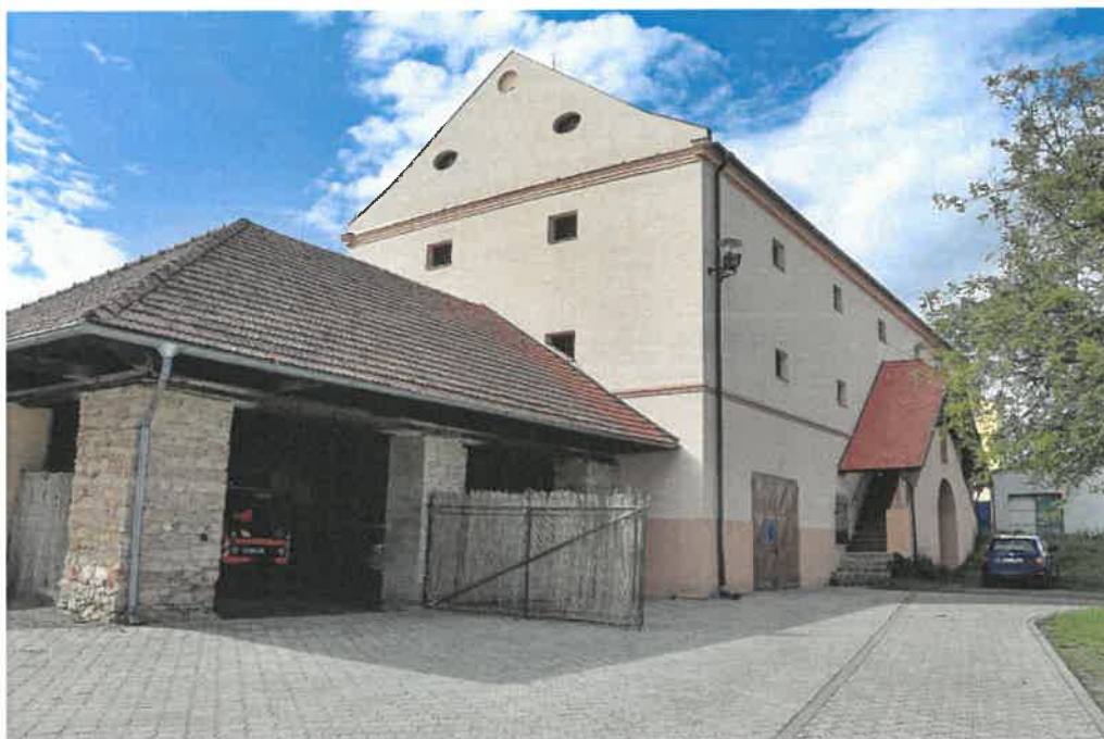
2. Pohled od jihu. V popředí přístřešek, který nebyl předmětem průzkumu.
