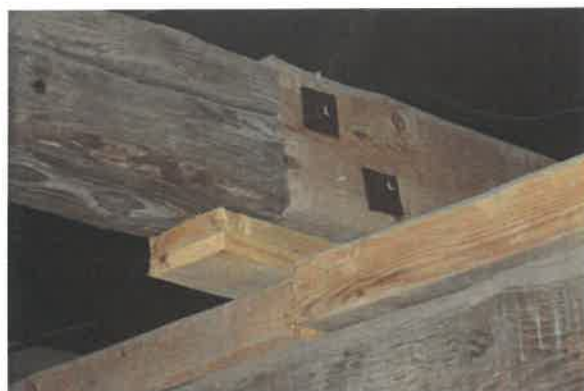
provedené opravy 3.NP
