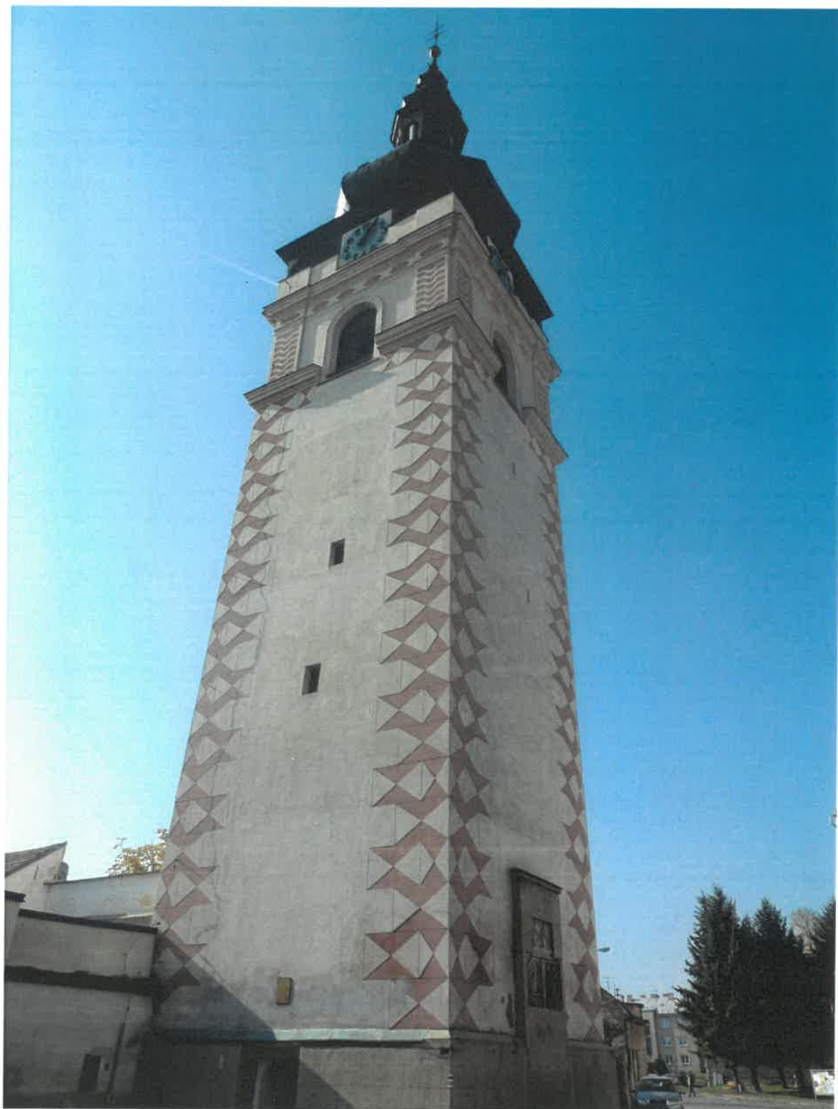
Městská věž, Komenského náměstí (obnova venkovního pláště, restaur. práce sgrafita – psaníčka)
