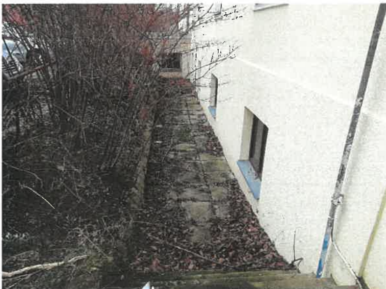
Jižní část západní stěny je do výše 0,2 m pod parapety zahrnuta terénem.
