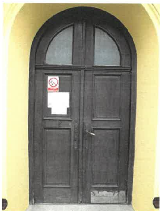
Fotografie před a po výměně vchodových dveří v r. 2013:
