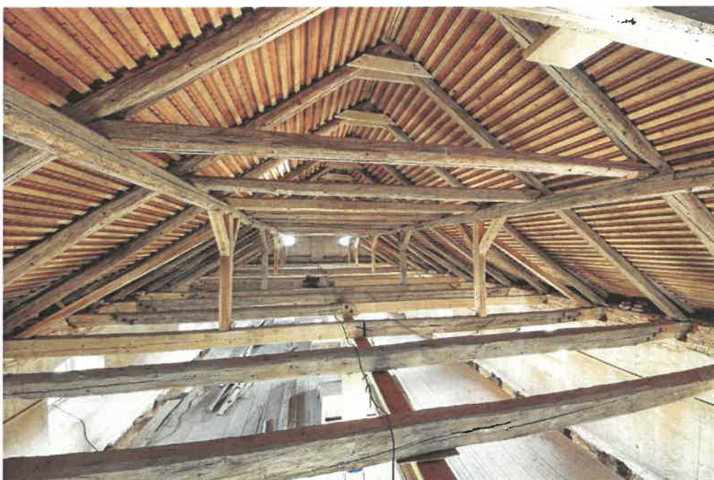
24. Konstrukce krovu
