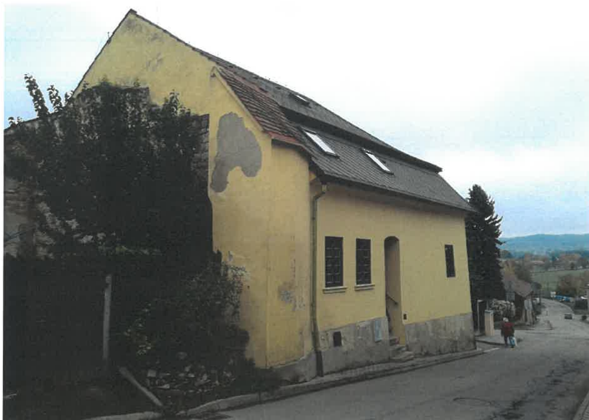
Městský dům čp. 224, ul. Olomoucká (obnova pískovcového soklu)
