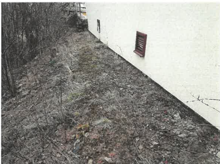
Zemní těleso při severní stěně. Pod terénem je osazena nopová folie.
