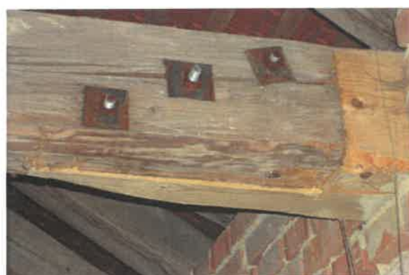
opravené zhlaví 3.NP
