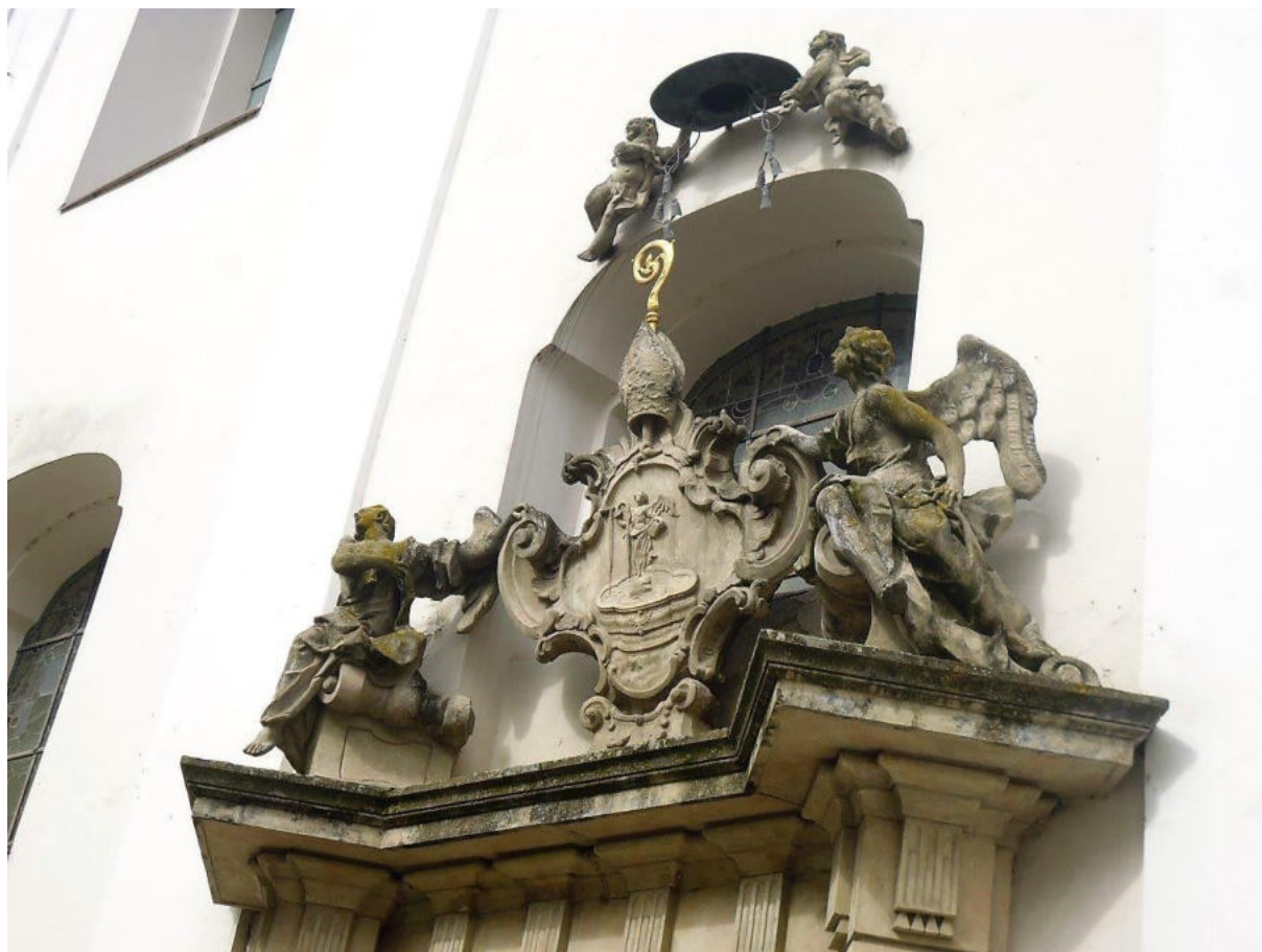
Fotografie před a po restaurování vstupního portálu v r. 2018:
