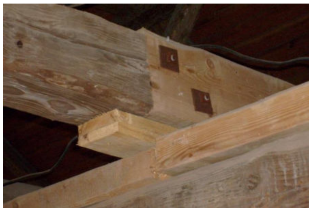
provedené opravy 3.NP
