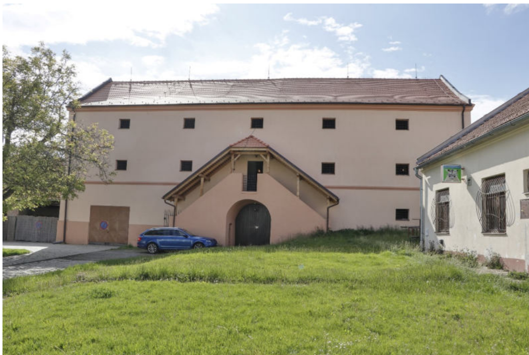
3. Pohled od východu.
