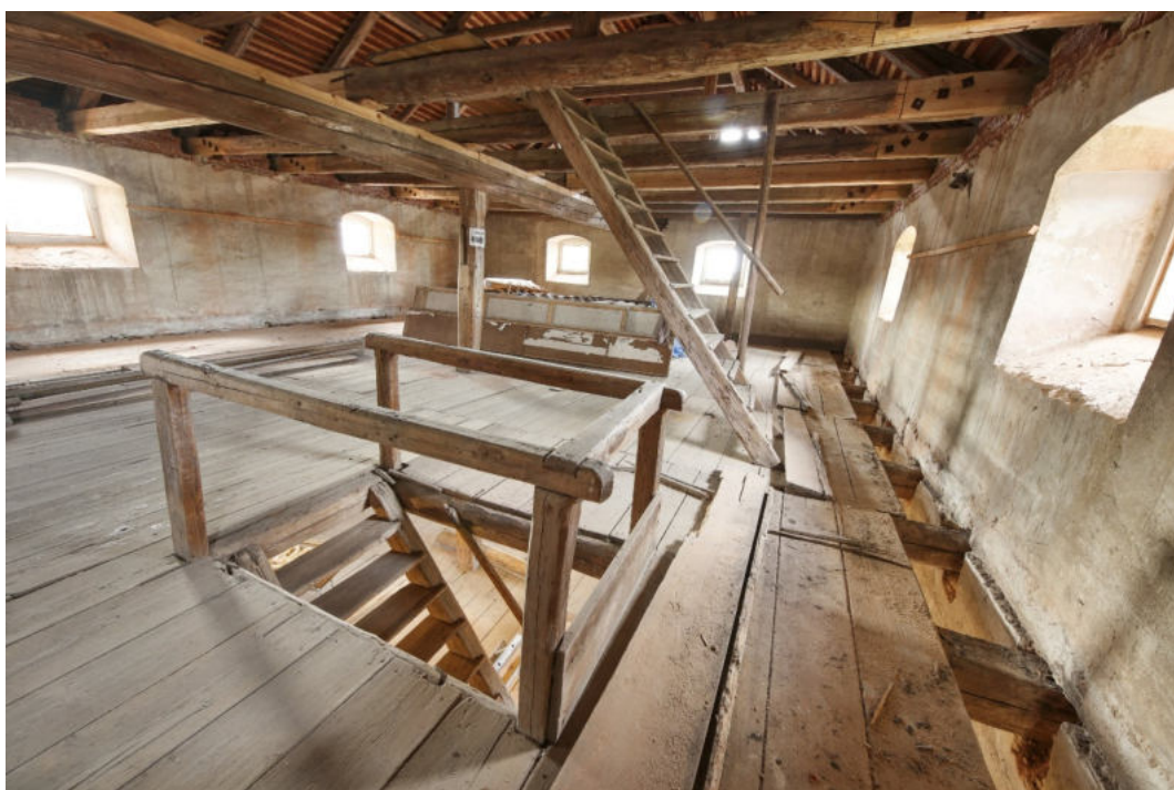
22. Prostor 3. nadzemního podlaží - pohled k severní části
