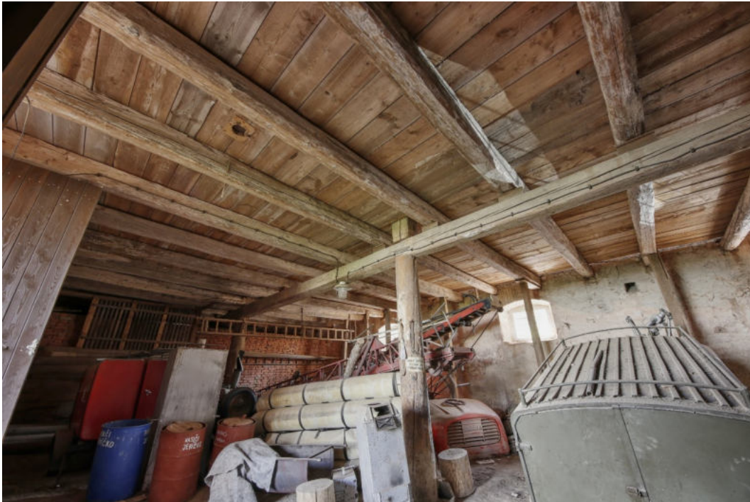
5. Prostor 1. nadzemního podlaží - pohled k severní části.
