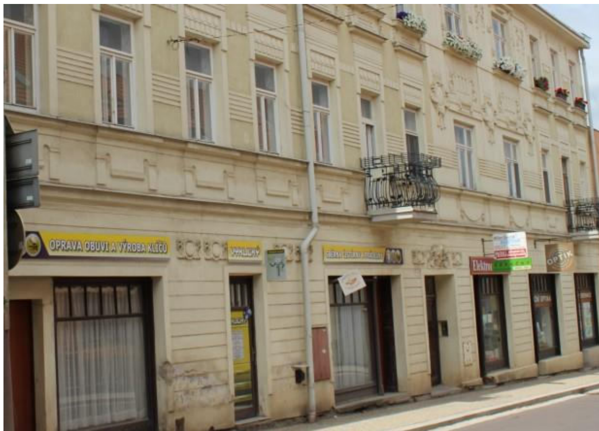
Průčelí městského domu čp. 71 před obnovou v r. 2017 a po obnově v r. 2018:
