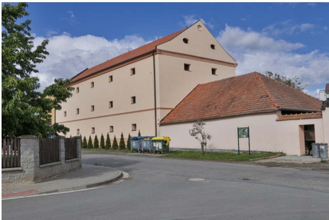
1. Pohled na sýpku od západu.
