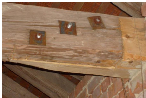
opravené zhlaví 3.NP
