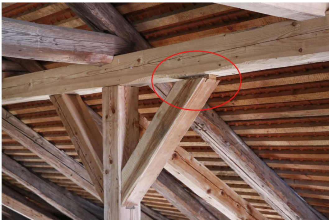
32. Nový pásek s čepovým spojem s vaznicí, nezajištěným kolkem. Nebezpečí uvolnění spoje a pádu pásku do prostoru 3. NP
