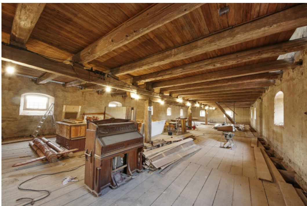
14. Prostor 2. nadzemního podlaží - pohled k severní části
