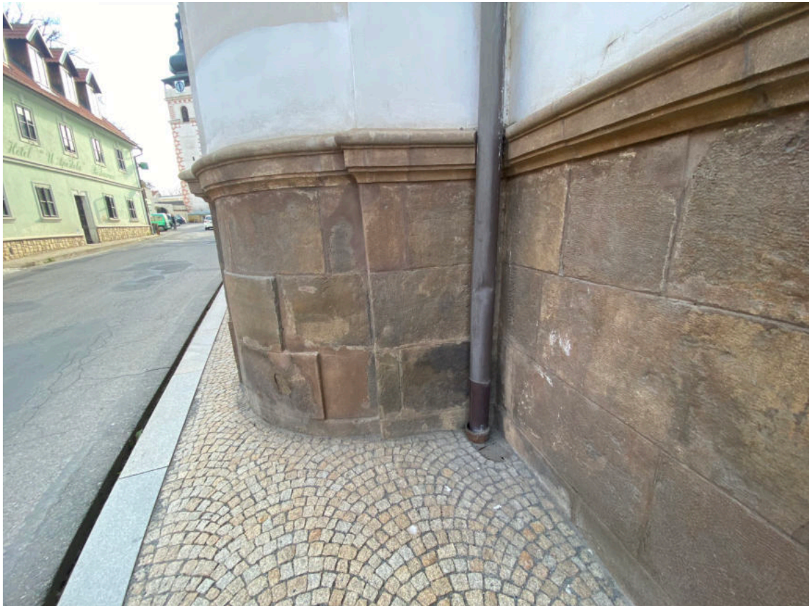
Dole 2. dešťový svod s čistící šachtou.
