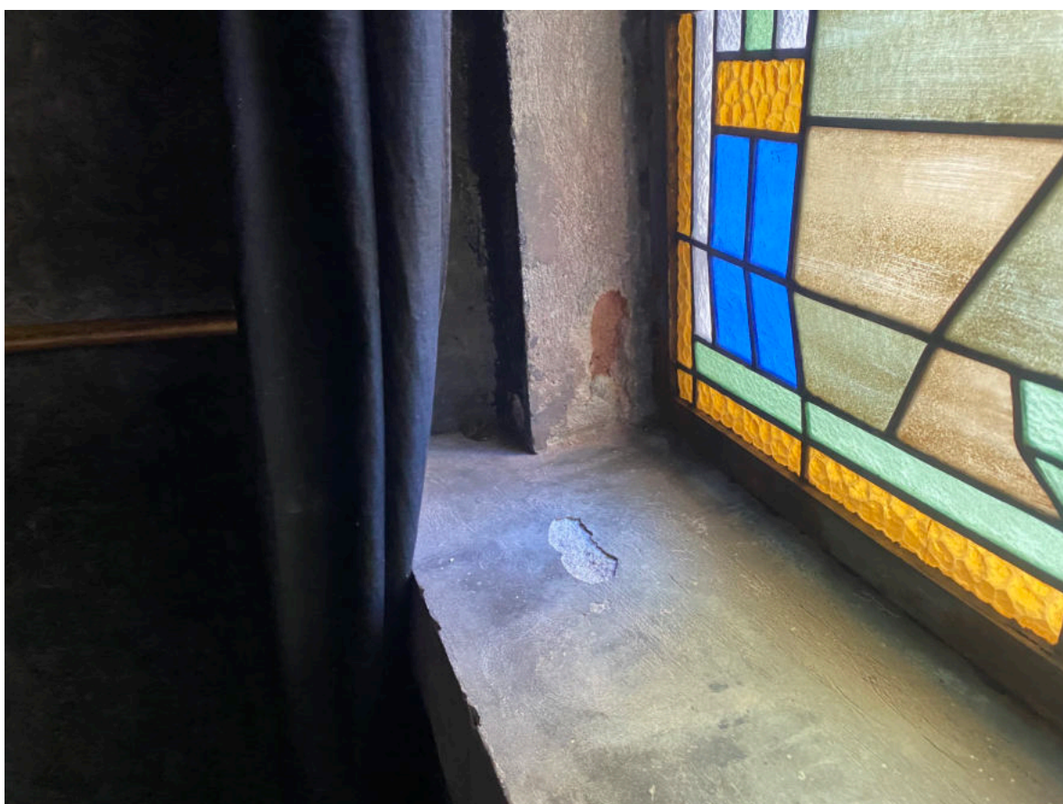
Pohled na cementem pokrytý parapet a cihlovou přizdívku oken
