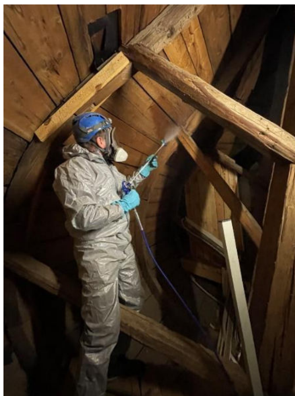
e) chemické ošetření dřevěných konstrukcí střešní bání městské věže:
