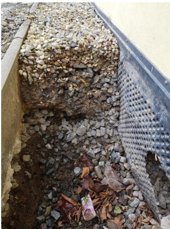
Dole vlevo okenní nika v jižní polovině chodby (okno z západu), vpravo nopová folie a zásyp výkopu podél východní stěny
