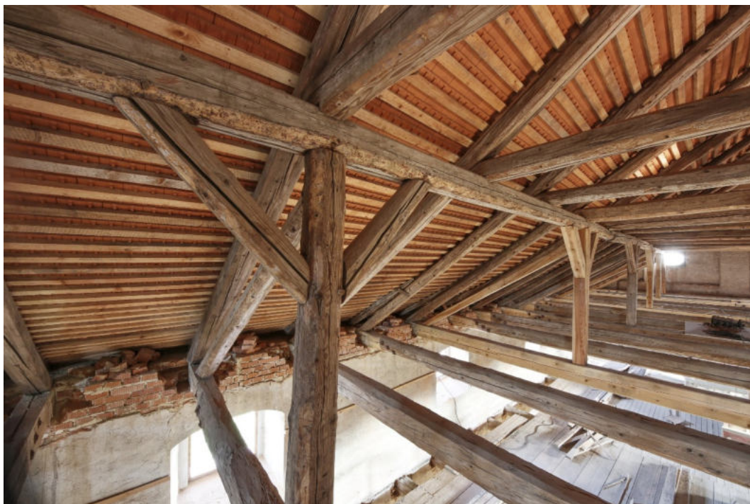
25. Konce vazných trámů zazděné do koruny zdiva z nových plných cihel a znovu vysekané ze zazdění v rámci průzkumu
