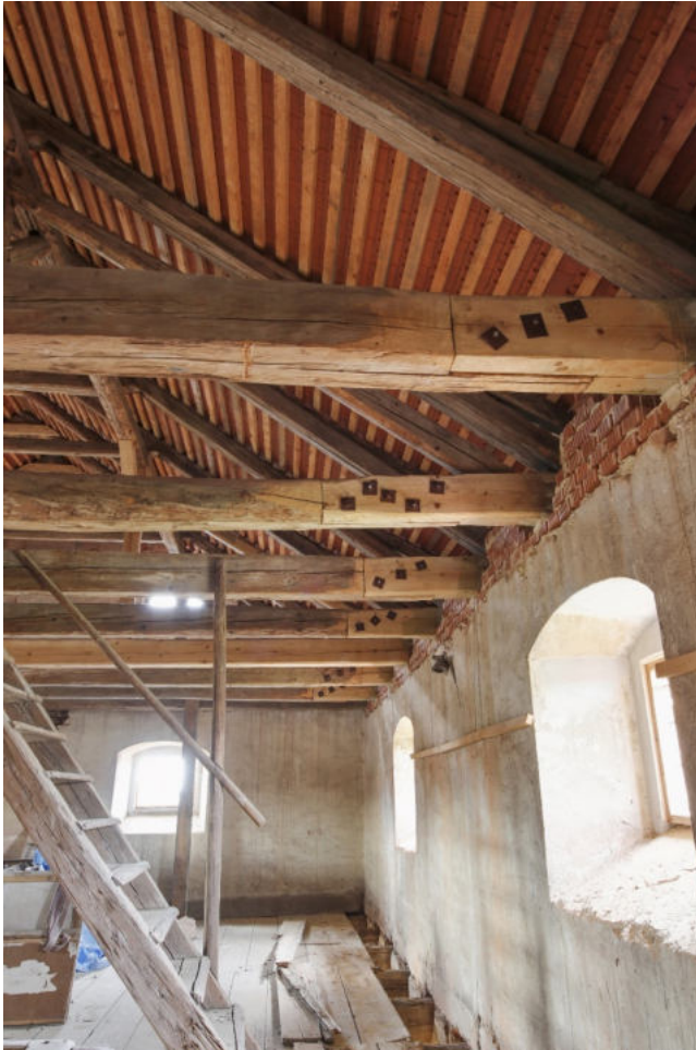
23. Protézování vazných trámů s plátovými svorníkovými spoji, provedené v rámci opravy krovu a střechy po roce 2010
