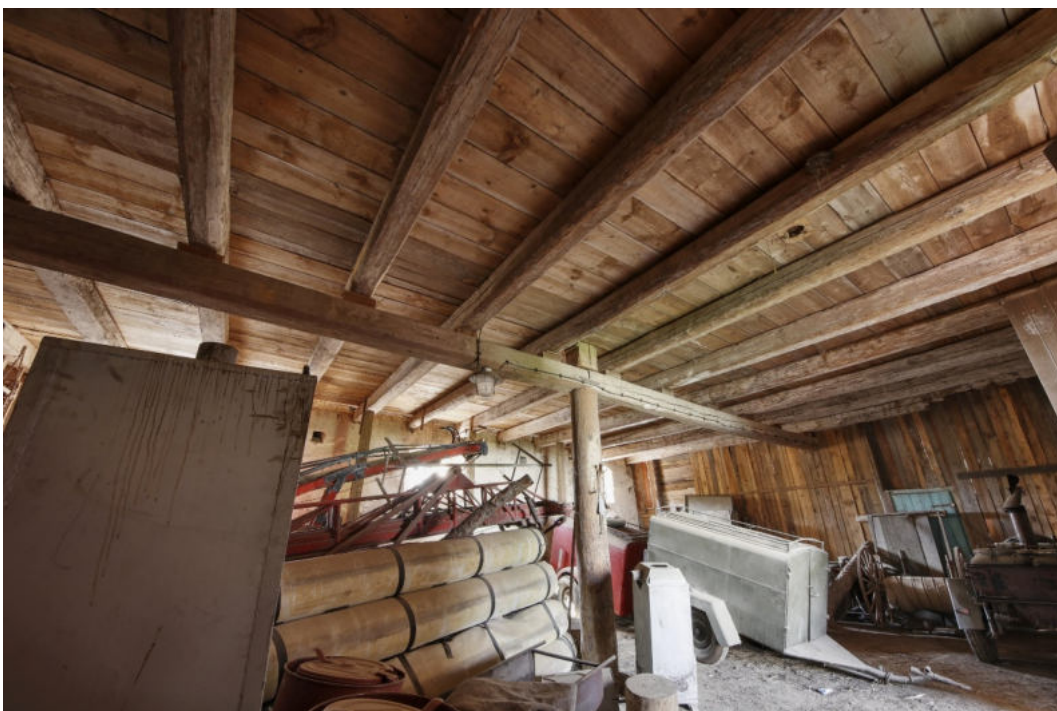
6. Prostor 1. nadzemního podlaží - pohled k severní části.
