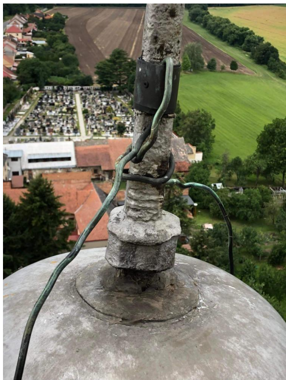
c) kontrola stability vrcholového kříže kotveného ke krovu městské věže.
